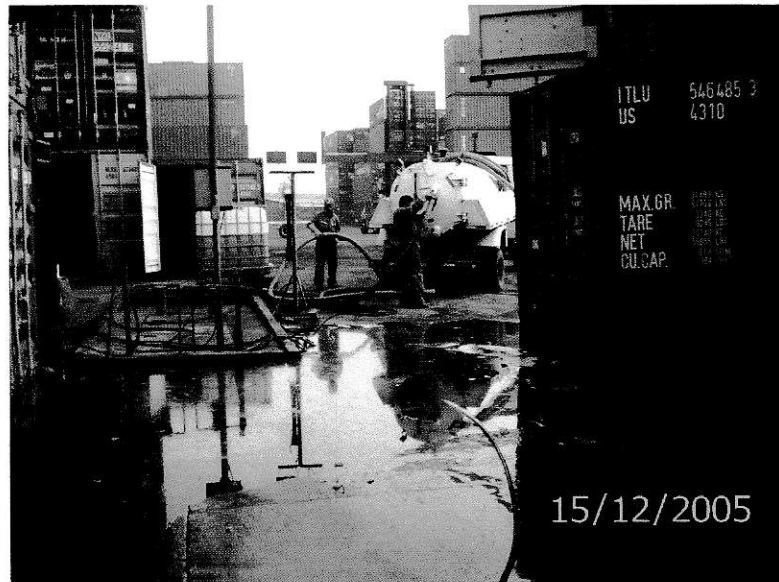
Figura 5: Situación Zona de Lavado
