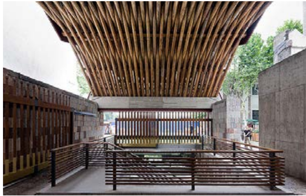
IMAGEN 4.5 Cubierta de troncos de madera en el espacio de acceso al Museo de la Academia de Arte de Zongshan. Fuente: La materialidad expresiva de Shu y Wenyu, Federico García, 2015.
