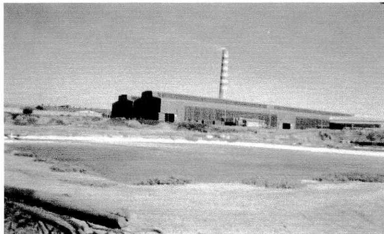
Figura 10: Piscina de Decantación de Riles
