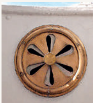
Figura 41. Sistema de ventilación Fuente: Libro "Faros del Estrecho de Magallanes", Martín y Fernández (2019)
