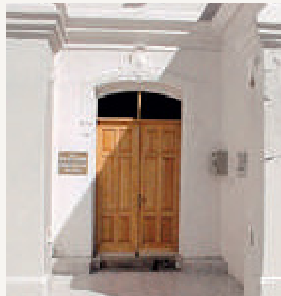
Figura 39. Detalle en acceso, faro Punta Delgada. Fuente: Libro "Faros del Estrecho de Magallanes" de Martín y Fernández (2019)
