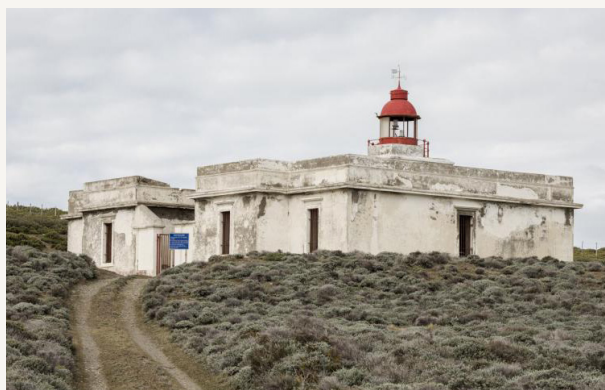
Figura 42. Vista del faro desde el acceso Fuente: Consejo de Monumentos Nacionales
