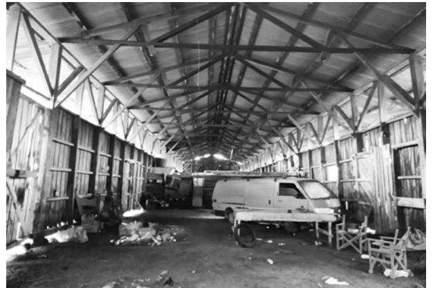
Figura 19. Interior bodega Puel (la mayor). Se observa la ocupación por personas en situación de calle
