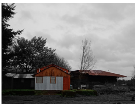
fig. 13 Vivienda sobre cimientos de ex-boletería
