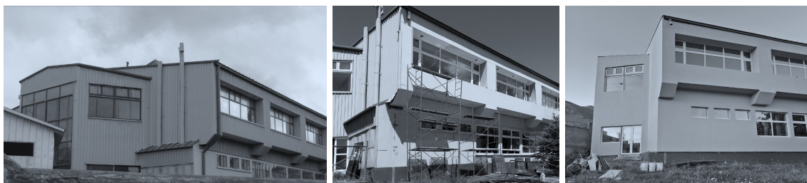
Fig. 8: Proceso de reacondicionamiento de la escuela Baquedano (antes–durante–ahora, respectivamente). Contempló un cambio de envoltente a un sistema de aislación EIFS, un recambio del 100% de las ventanas existentes a unas de tipo termopanel con marcos de PVC, un cambio de la techumbre a uno con mayor aislación, mejora de radiadores y el reemplazo de luminarias existentes a unas LED. Elaboración propia en base a (EBP, 2021).
