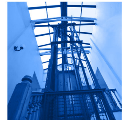
Escalera principal, tercer piso.
