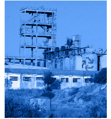
Fig. 5 Fotografía de vacío urbano de tipo funcional. Fuente: https://www.f3arquitectura.es/urbanismo/vacios-urbanos-ii/
