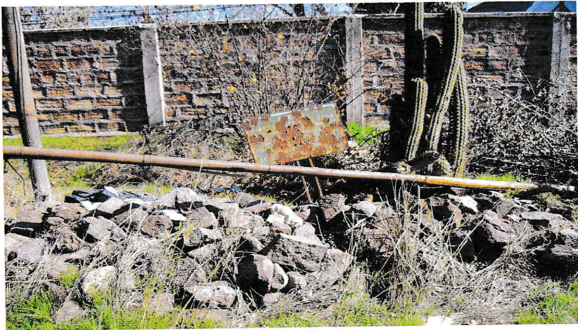
Figura 12. Situación actual de la zona de acopio de escombros II.
