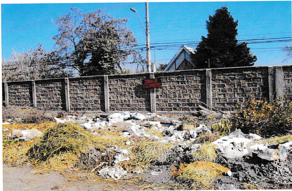
Figura 11. Situación actual de la zona de acopio de escombros I.
