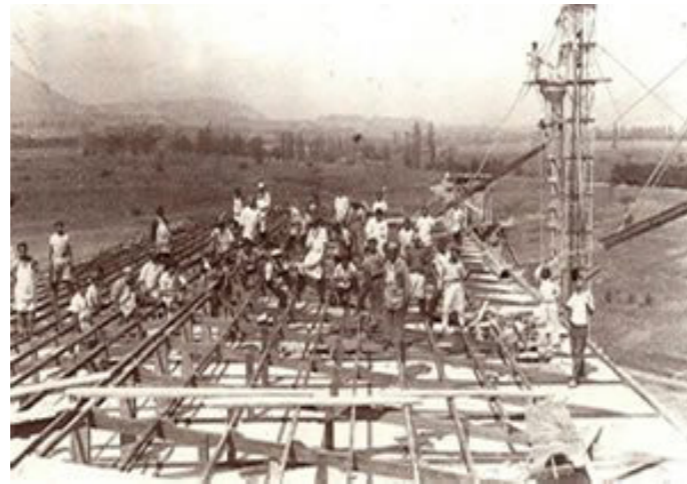
Figura 32: Construcción del Sanatorio El Peral. Fuente: Hospital Dr. Sótero del Río website: https://www.hospitalsoterodelrio.cl/web/historia/
