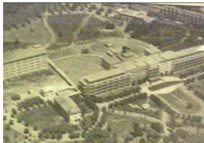
Figura 34: Hospital Sanatorio El Peral. Fuente: Hospital Sótero del Río website: https://www.hospitalsoterodelrio.cl/web/historia/
