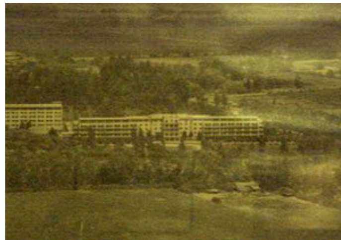
Figura 33: Hospital Sanatorio El Peral. Fuente: Hospital Sótero del Río website: https://www.hospitalsoterodelrio.cl/web/historia/
