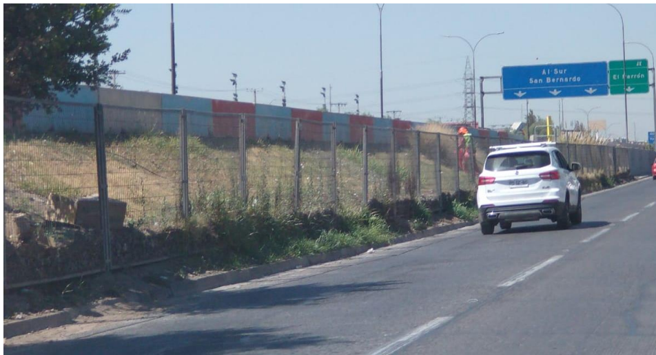
Imagen 33: Borde Autopista Central, Lo Espejo. Fuente propia, 2021.
