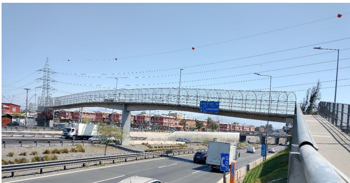
Imagen 31: Pasarela, Lo Espejo. Fuente propia, 2021.
