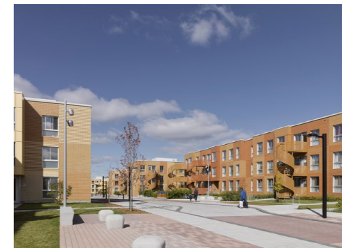
Complejo residencial Saint-Michel Nord / Saia Barbarese Toupouzanov Architectes
