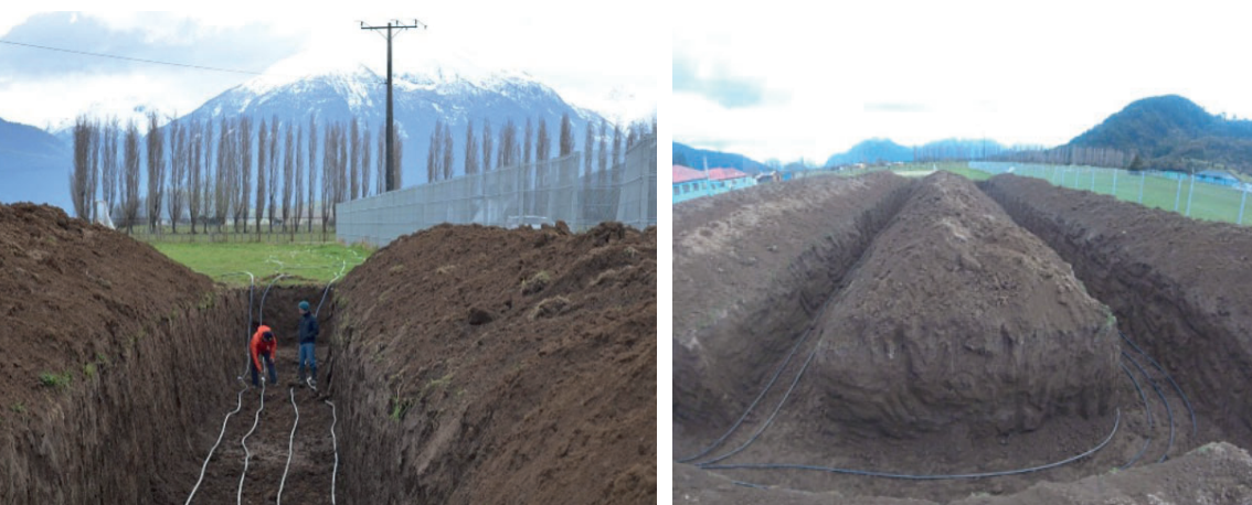
Figuras 3 y 4. Construcción del intercambiador de calor horizontal cerrado. Fuente: Archivo CEGA.
