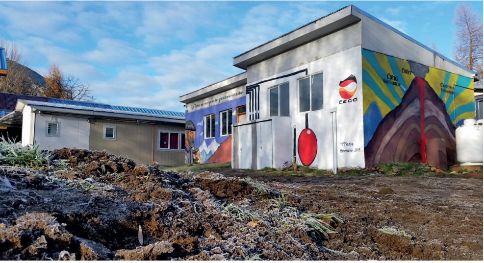
Figura 6. Sala de máquinas del Liceo Altos del Mackay. Fuente: Archivo CECA.
