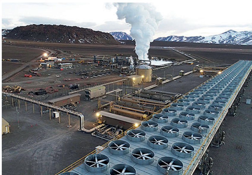
Figura 4. Planta de producción de electricidad con geotermia Cerro Pabellón. Fuente: Archivo CEGA.
