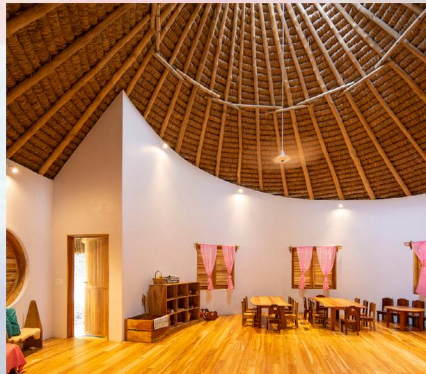
Nota. Según los propios arquitectos “El techo es una estructura recíproca auto soportada de piezas de madera rolliza entrelazadas entre sí que sigue la forma de la espiral. La cubierta está minuciosamente confeccionada por un tejido de zacate en forma de capas según la tradición indígena del sur de Costa Rica”. Tomado de (Andrés García Lachner ©)
