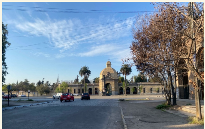
Vista de la Plaza desde la Avenida La Paz, se observa el descuidado estado de sus jardines. Fotografía del autor.
