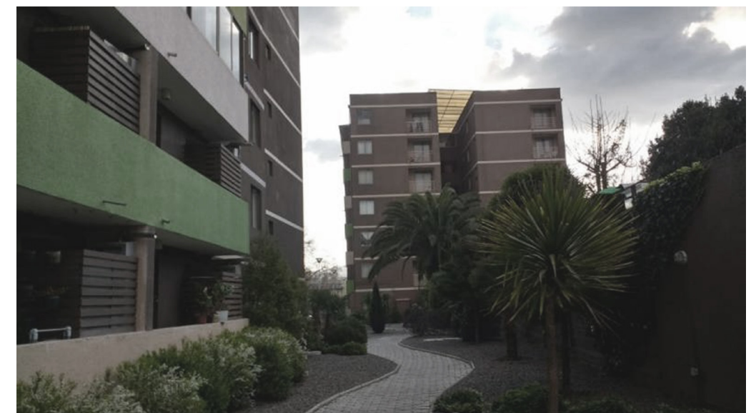
Figura 22. Calle cerrada en el condominio Las Heras Poniente. Fuente: toppropiedades.cl.
