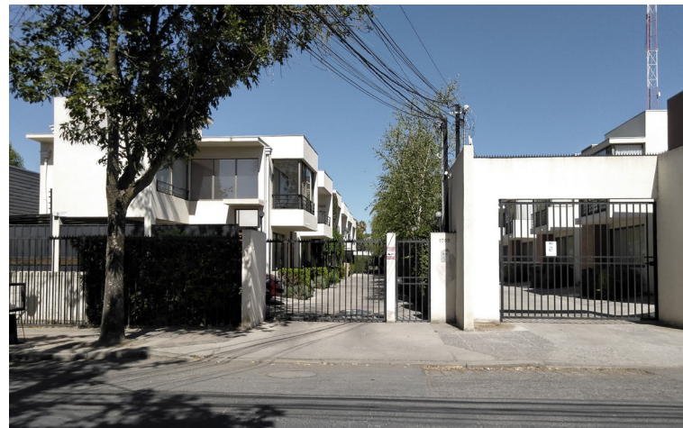
Figura 3. Condominio Las Heras ubicado en 5 Oriente 1755. Fuente: Fotografía del autor.
