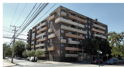
Figura 27 Condominio Las Heras Oriente. Fuente: Fotografía del autor
