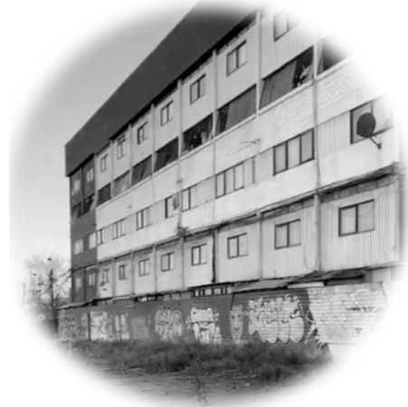
Blocks de viviendas Carabineros
