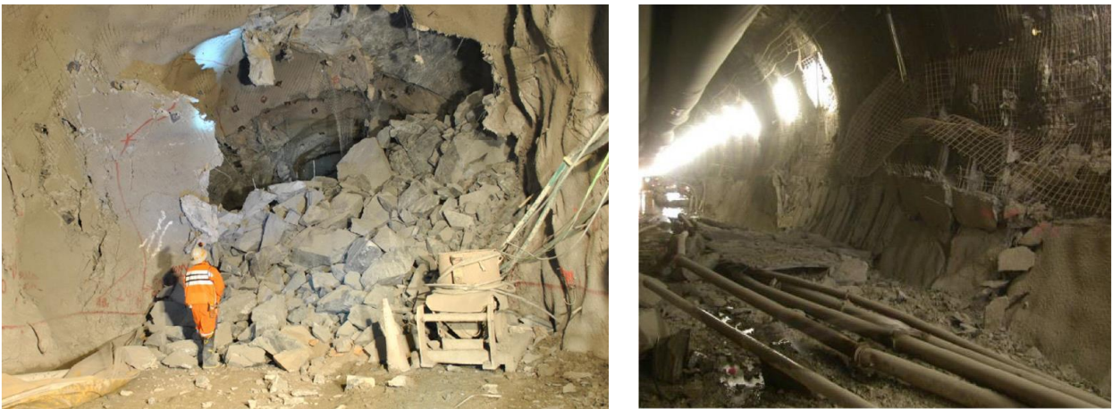
Figura 1: Ejemplo de desprendimiento de roca producto de estallidos de roca. Figura 1a (izq.) muestra estallido de roca en mina El Teniente en Chile (Rojas, 2017). Figura 1b (der.) muestra estallido de roca en el túnel Gottard en Suiza (Rehbock-Sander & Jesel, 2018).
