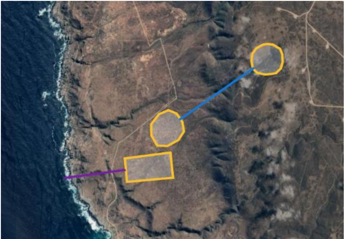
Figura 89: Vista en planta de reservorios y desalinizadora. Fuente: Elaboración propia obtenida de Google Earth.
