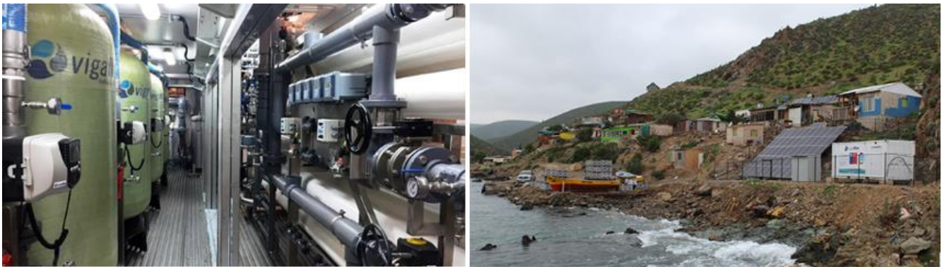
Figura 119: Sistemas de desalinización Vigaflow. Fuente: Vigaflow.
