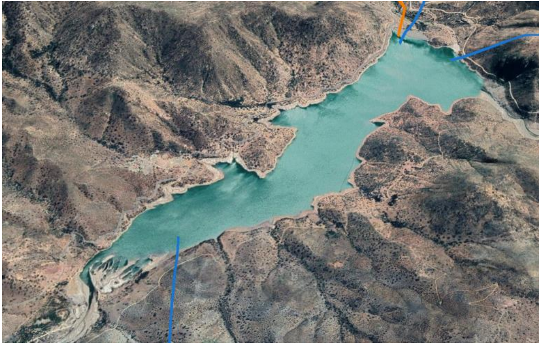
Figura 72: Embalse Corrales usado como reservorio inferior. Fuente: Elaboración propia obtenida de Google Earth.
