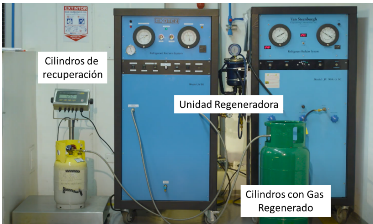
Ilustración 22: Diagrama de regeneración de gas refrigerante
