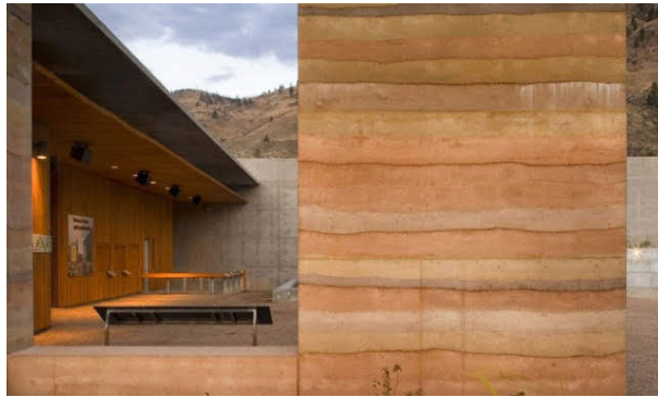
24 Terminación muro en base a Rammed Earth.
