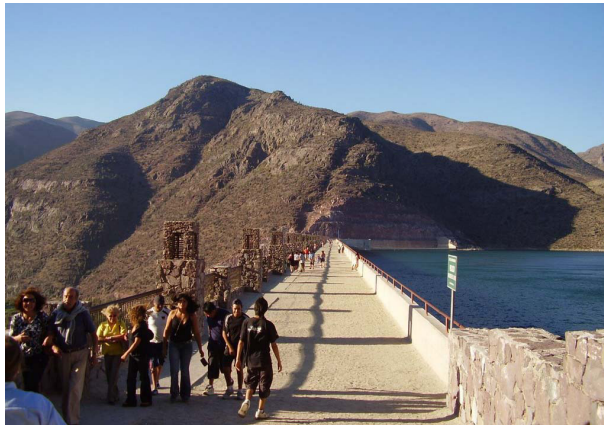
20. Muro de Contención Embalse Puclaro
