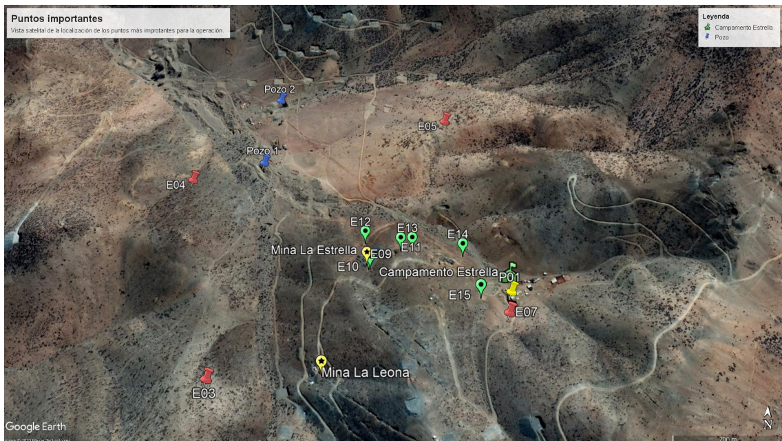
Figura B.1: Imagen satelital con la localización de los puntos estratégicos para la operación.
