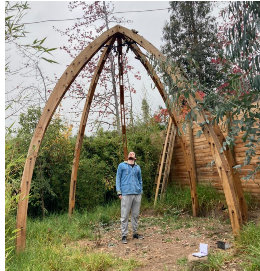
FIGURA 32: Prototipo pepino y cuadernas de madera, elaborado por Patricio Gerra, autor original del proyecto Cobijo + Pepino.
