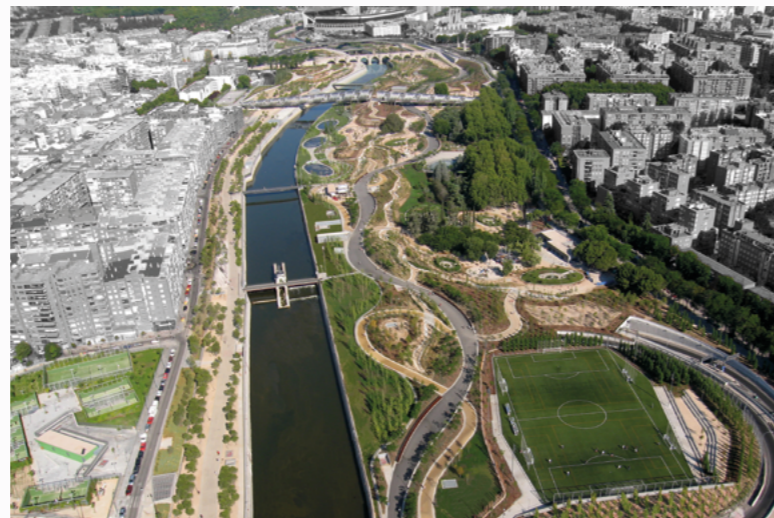
Figura 91. Madrid Río. Fuente: Burgos & Garrido arquitectos.
