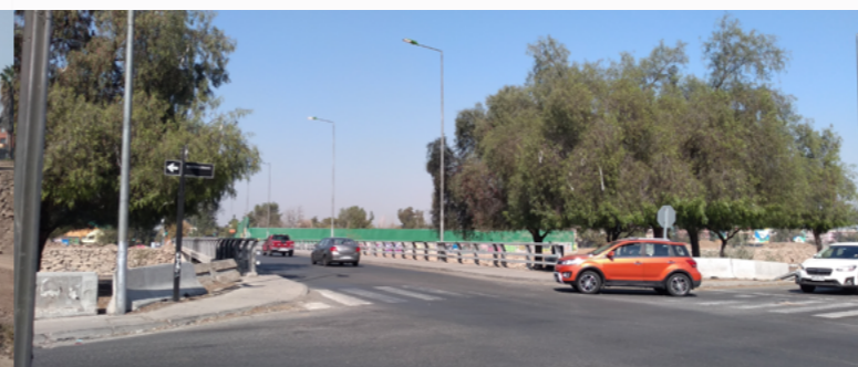
Figura 71. Puente Resbalón. Fuente: Elaboración propia.
