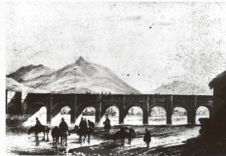
Figura 25. Puente de Cal y Canto. Fuente: Biblioteca Nacional Digital de Chile.
