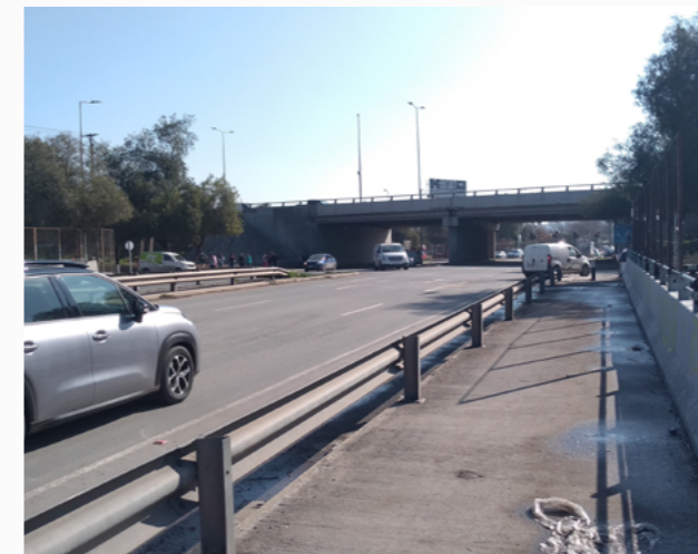
Figura 82. Límite oriente: Puente Carrascal. Fuente: Elaboración propia.
