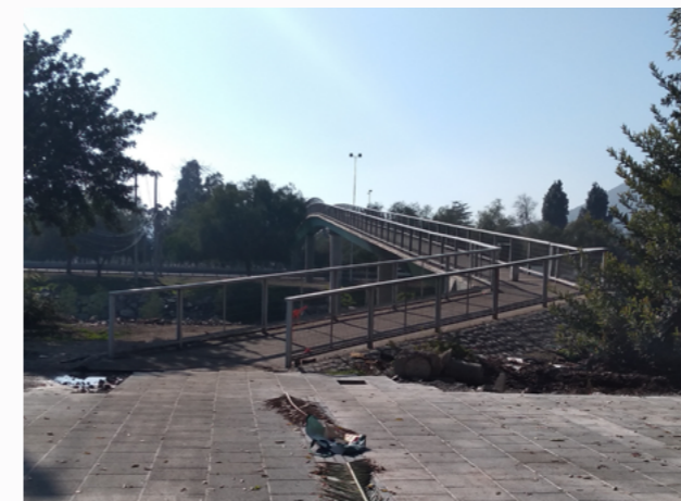
Figura 78. Límite poniente: pasarela peatonal. Fuente: Elaboración propia.
