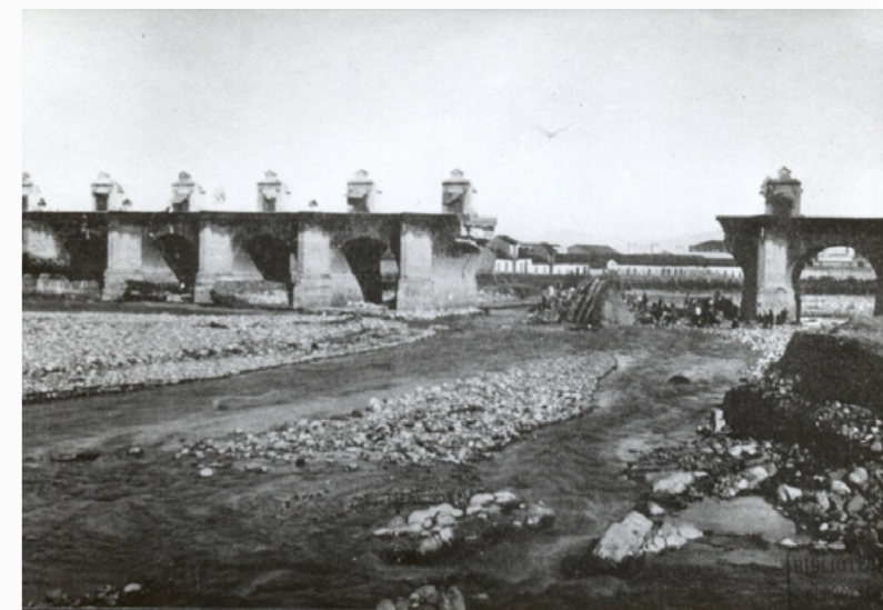
Figura 26. Caída de tres arcos de Puente Cal y Canto. Fuente: Biblioteca Nacional Digital de Chile.
