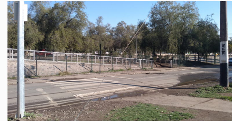
Figura 89. Acceso pasarela desde Renca. Fuente: Elaboración propia.
