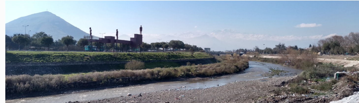
Figura 86. Vista del polígono desde ribera sur. Fuente: Elaboración propia.
