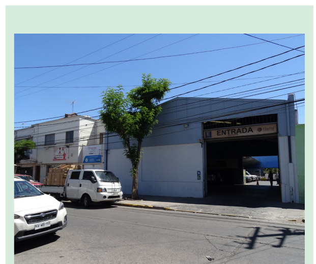
Fig. 17: Calle Pedro León Ugalde. Fuente: Elaboración propia.
