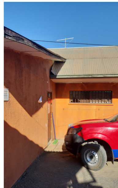
Acceso a oficinas DIDECO
