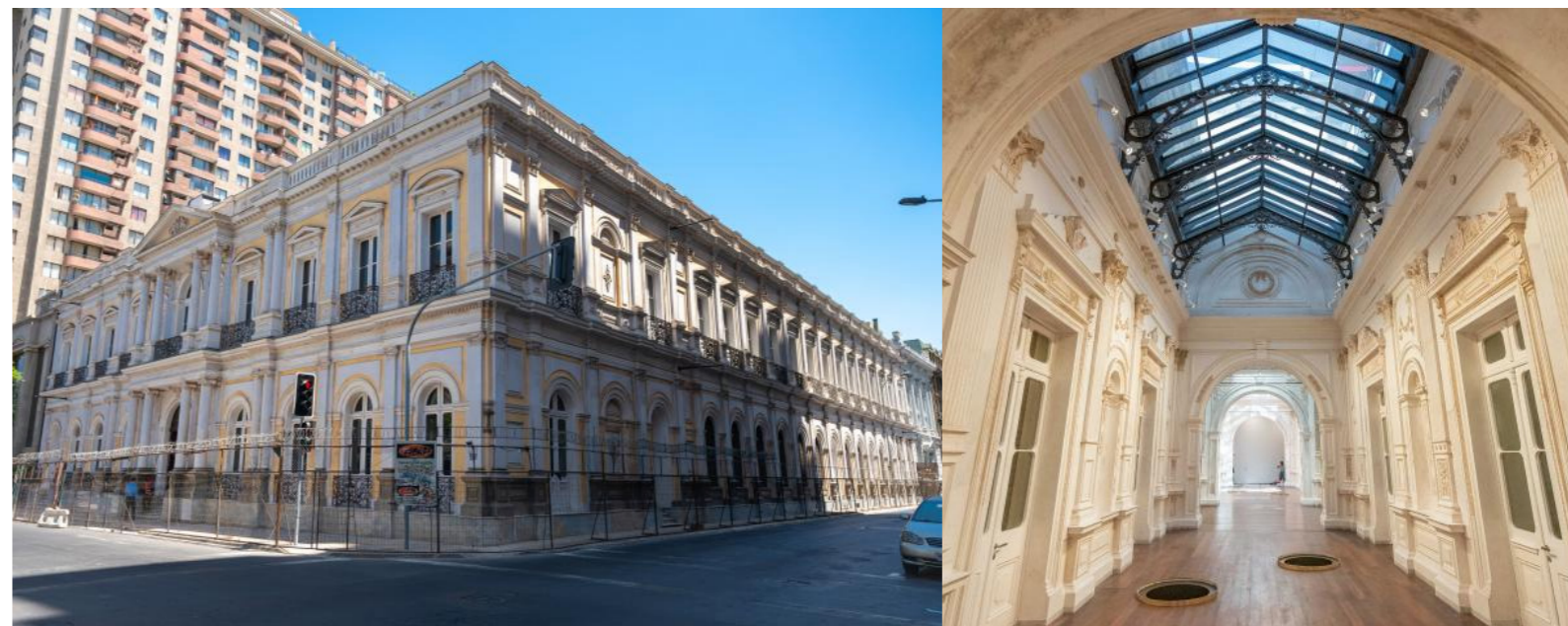
Figura 4. Palacio Pereira, ubicado en Huérfanos 1515 Fuente: www.monumentos.gob.cl
