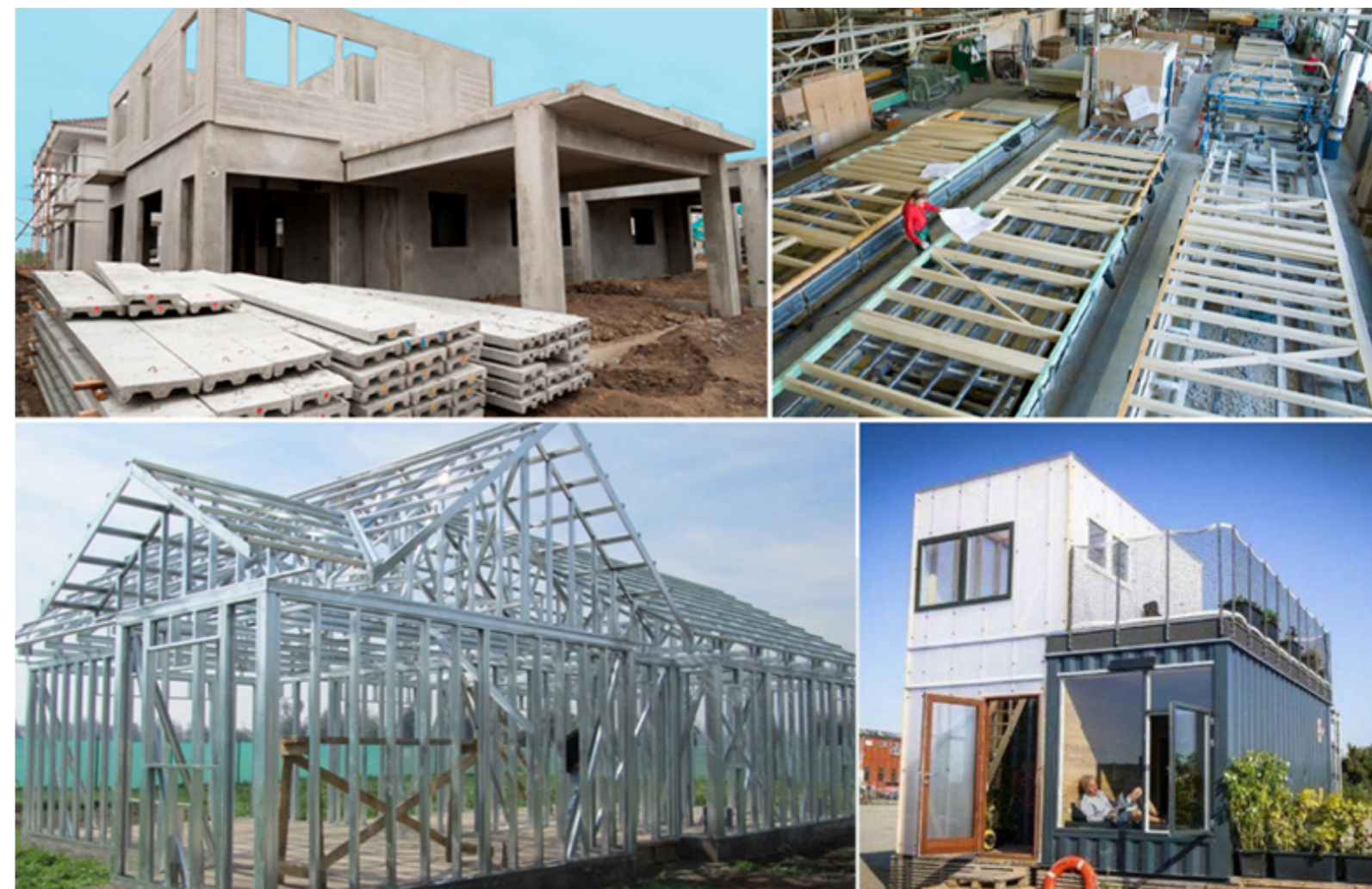
Figura 16. Elementos prefabricados de hormigón, madera, metal y container respectivamente.
