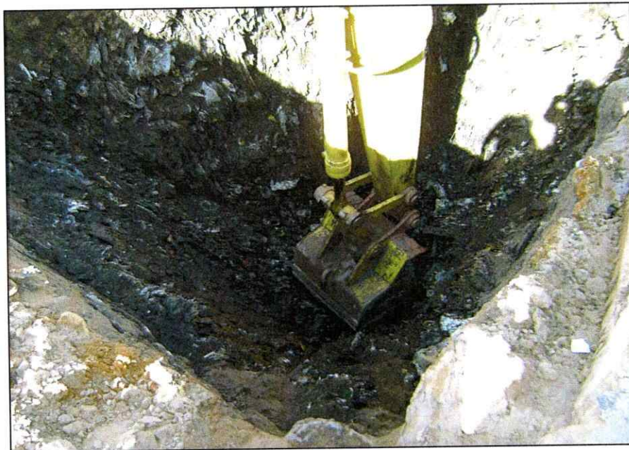
Figura 6. Calicatas realizadas en ambos Rellenos Sanitarios.
