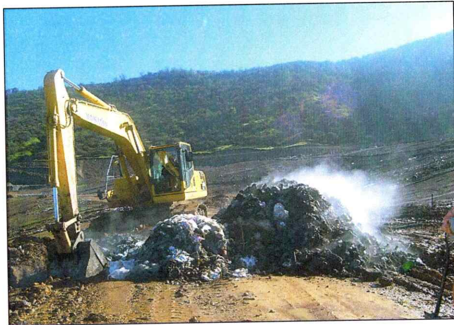
Figura 7: Residuos degradados sacados de la calicata realizada en Relleno Sanitario Santa Marta.
