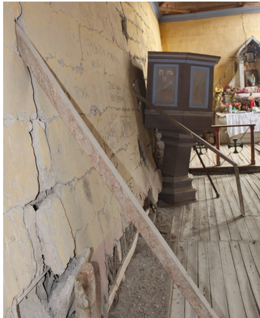
Figura 70. Refuerzos en fachada sur instalados al interior de la iglesia.
