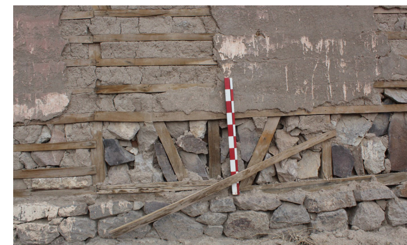
Figura 43. Fotografía tabique fachada norte iglesia. Fuente: Colección del autor (2022).
