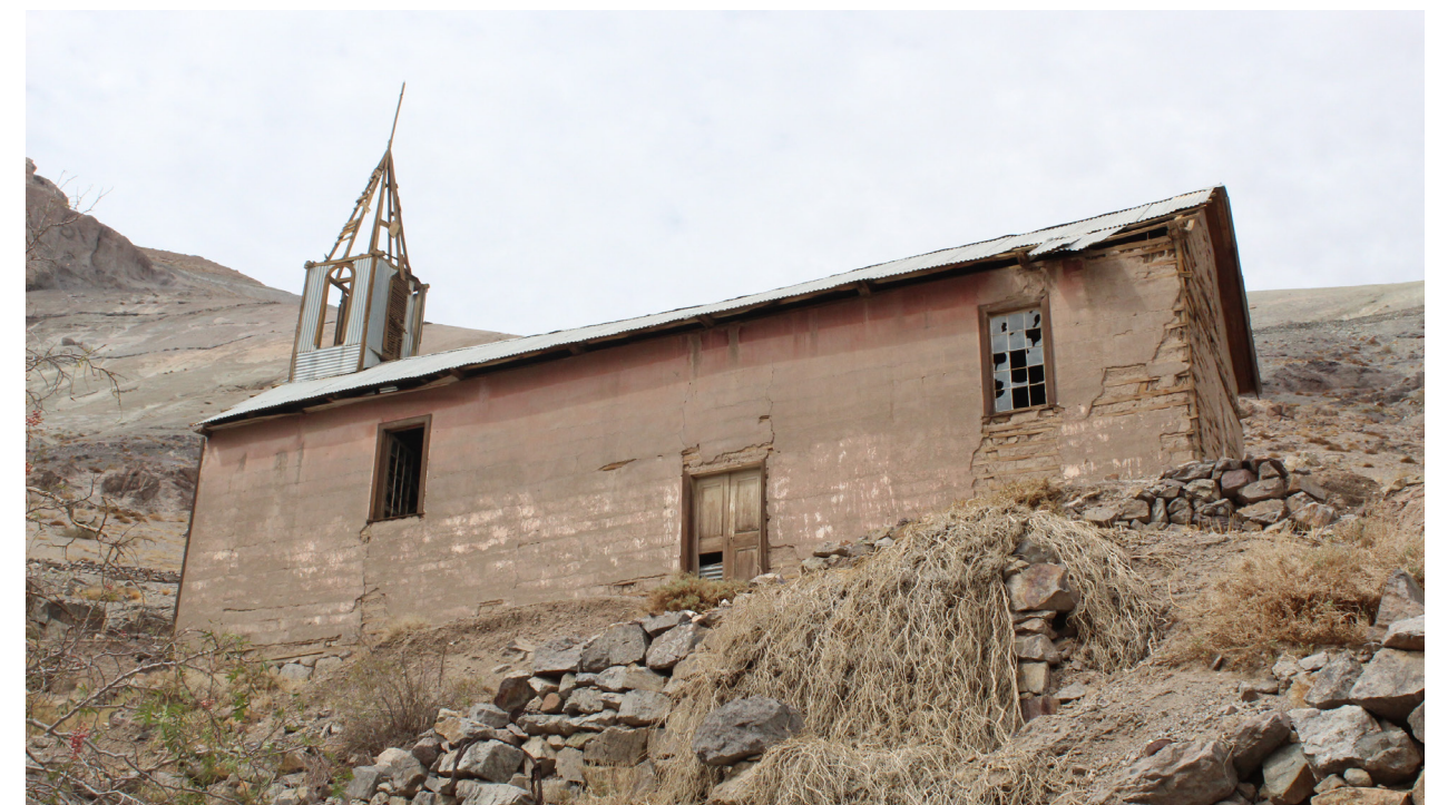
Figura 8. Iglesia de Cerro Blanco Fotografía de su fachada norte. Fuente: Colección del autor (2021).
