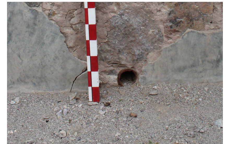
Figura 78. Tubo metálico de drenaje de agua en muro sur sedes social.
