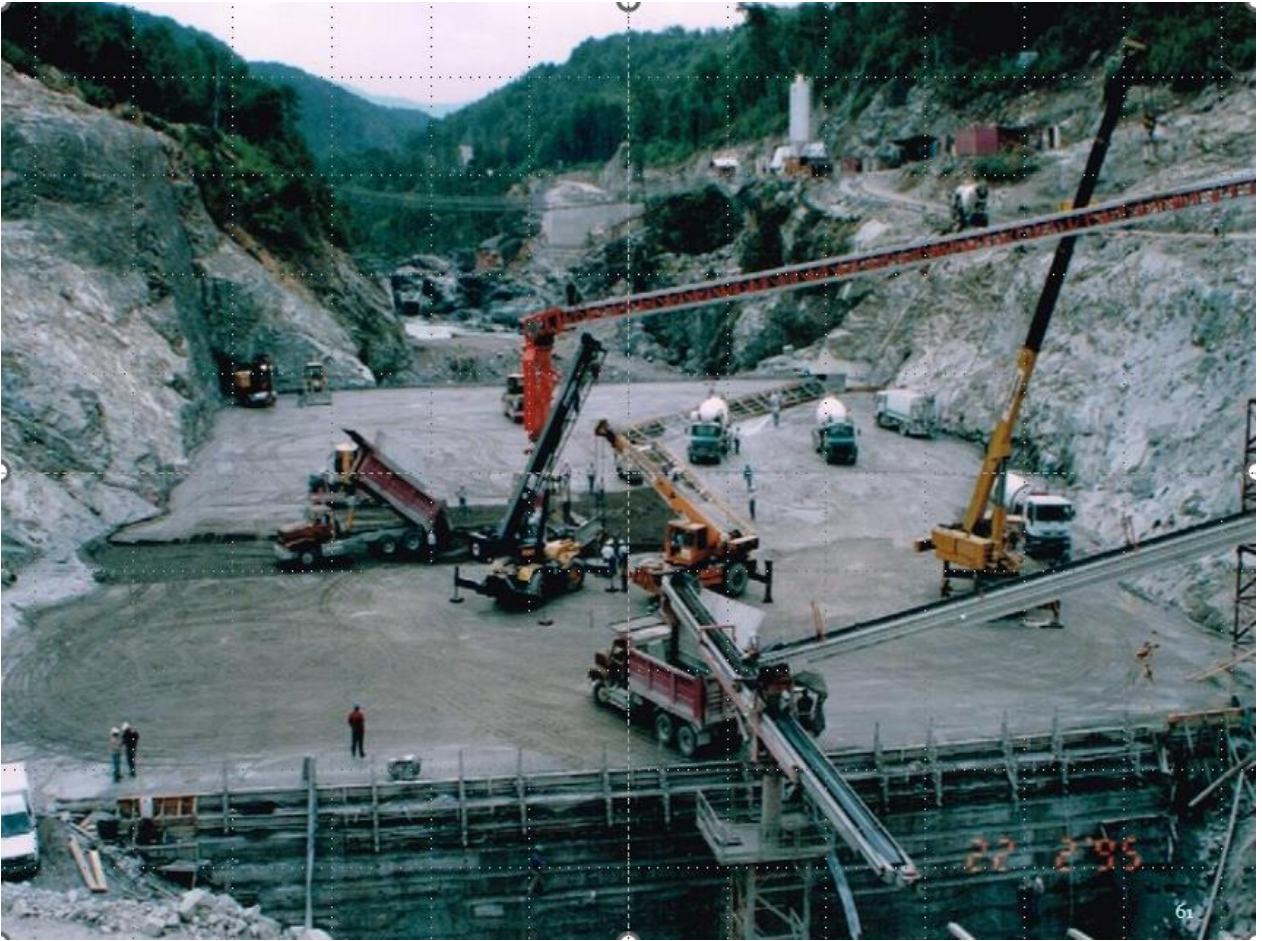
Ilustración 79: Uso combinado de cintas transportadoras y camiones en la construcción de la presa de la central Pangue, en niveles inferiores de la presa, con áreas pequeñas de colocación que no permitían instalar aun la Crawler Placer. Fuente: Adolfo Ochoa.
