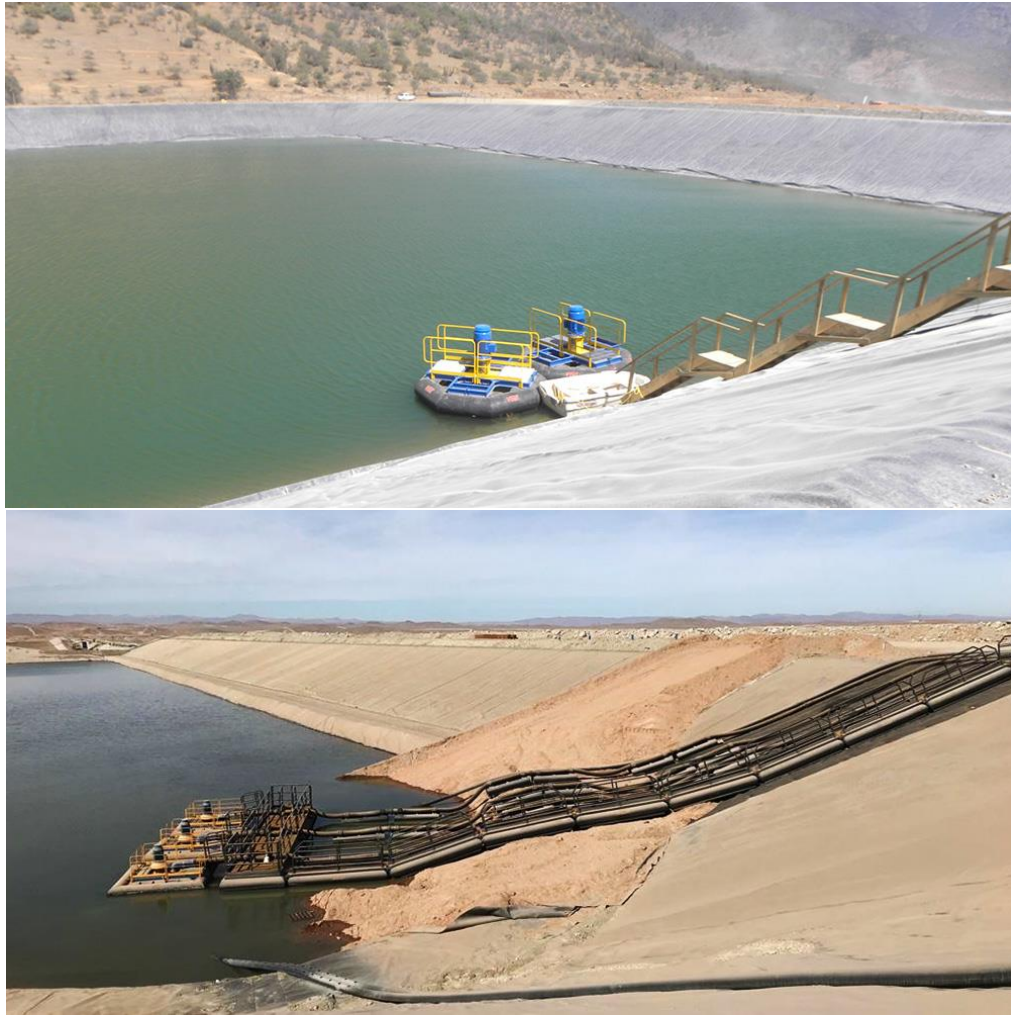
Ilustración 87: Ejemplos de bombas de balsa en eje vertical utilizadas para captación de aguas embalsadas. Fuente: vogt.cl
