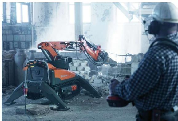
Figura 4.11: Robot de demolición. [Fuente:Hormigón al día (2022)]
