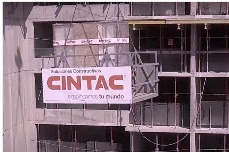
Figura 6.7: Montaje de baños prefabricados. [Fuente: Gentileza de Siena (2022)].
