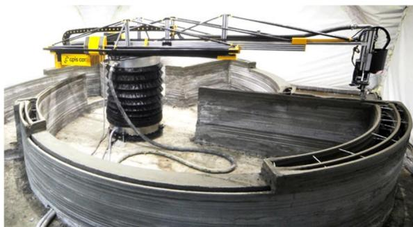
Figura 6.13: Impresión 3D de en hormigón. [Fuente:]
