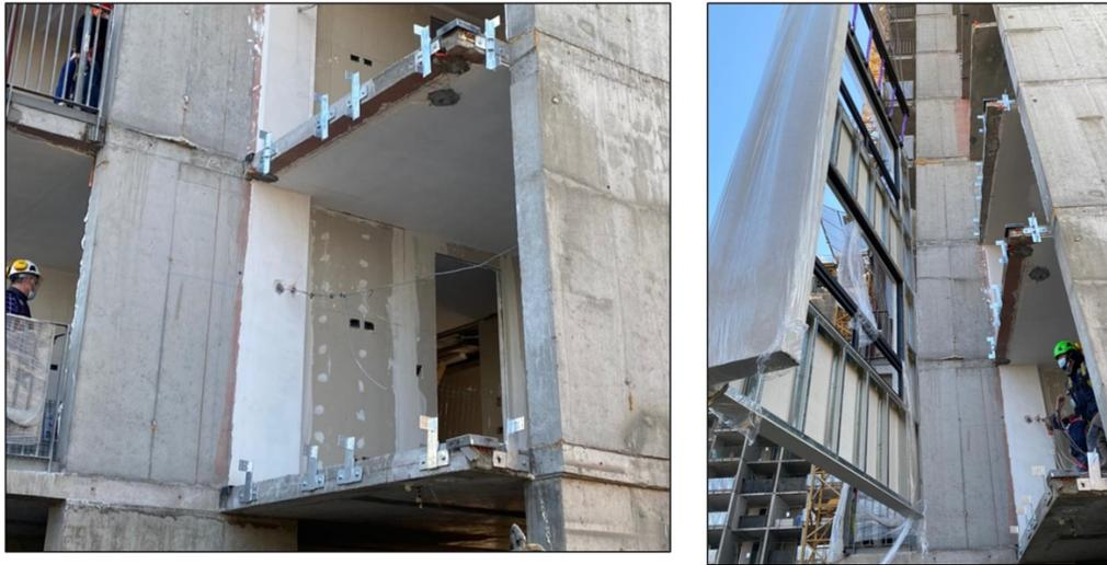
Figura 6.9: Montaje de fachadas prefabricadas. [Fuente: Gentileza de Siena (2022)].
