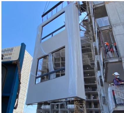
Figura 4.17: Instalación de fachadas prefabricadas. [Fuente: CDT (2022)]
