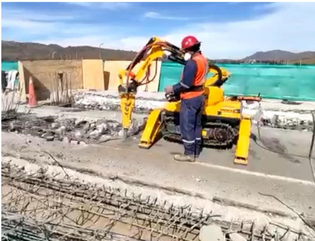
Figura 6.12: Robot de demolición Brokk en terreno. [Fuente: Gentileza de Brokk (2022)].
