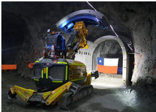
Figura 4.18: Montaje robotizado de muros de hormigón prefabricados en minería el Teniente. [Fuente: CDT (2022)]
