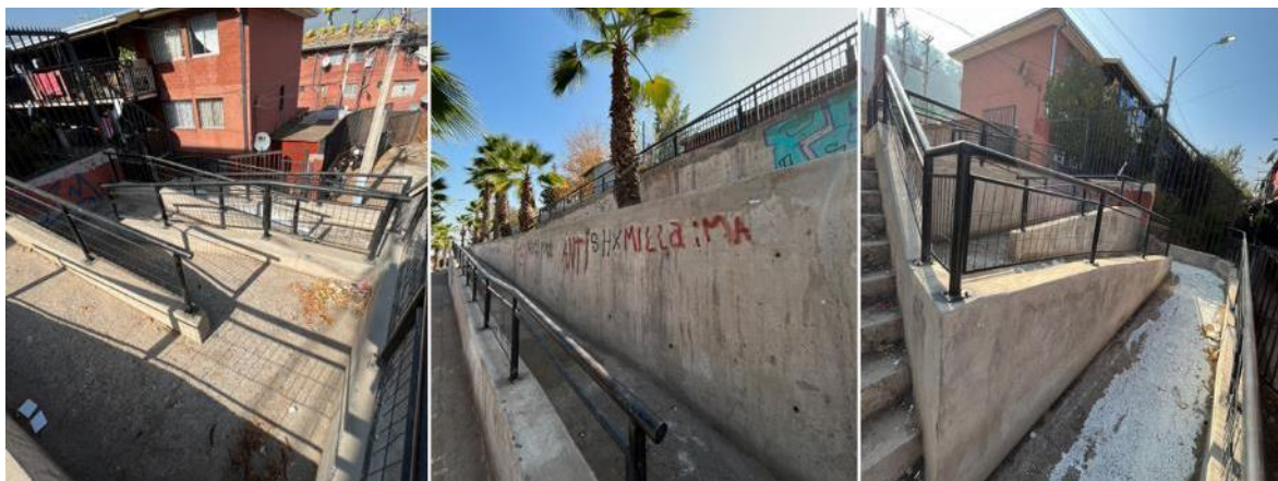
Imagen 6: Fotografías del estado y uso de las rampas.
