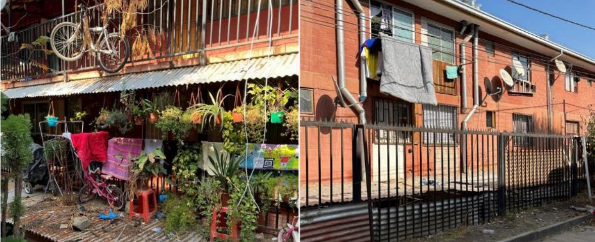
Imagen 14: Extensiones de la vivienda producto de la falta de espacio.
