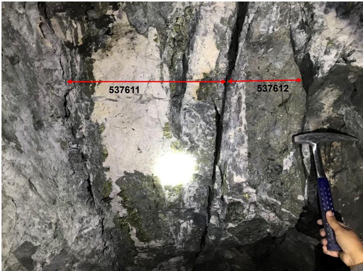
Figura 14: Fotografía de labor techo nivel 1055 m sector Norte. Se aprecian dos zonas: la primera se ubica hacia el sector izquierdo y corresponde a la veta principal y zona de brecha donde se obtuvo la muestra 537611. La segunda se ubica hacia el sector derecho y corresponde a una zona de stockwork y mineralización diseminada donde se obtuvo la muestra 537612.
