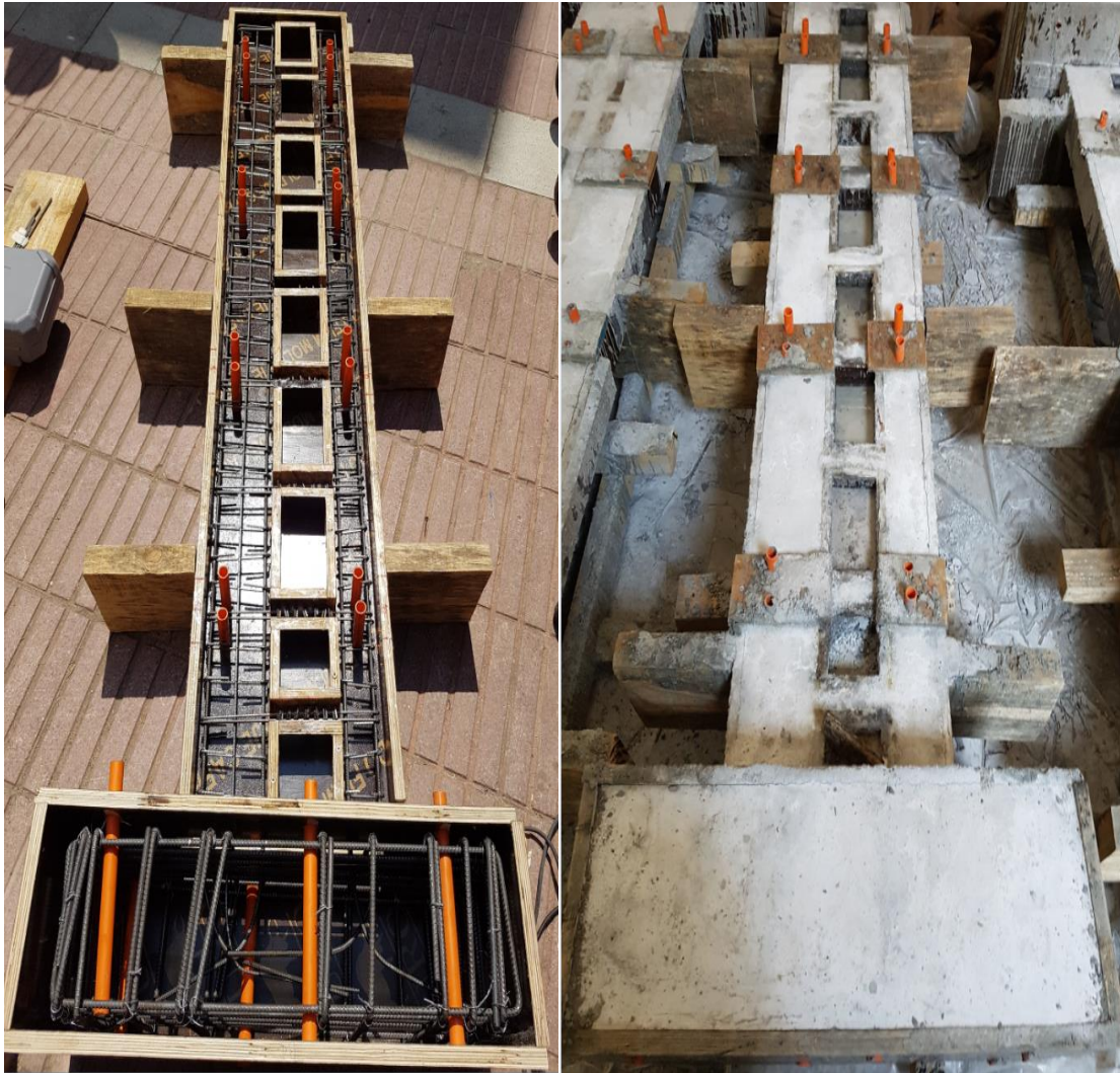
Figura 30: Moldaje y hormigonado Probeta PR-3 [Santos, 2018]
