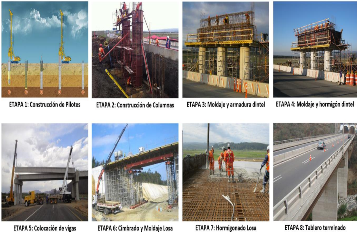
Figura 2: Construcción de puentes con metodología Convencional en Chile. Fuente: Análisis comparativo de construcción de puentes, utilizando el método convencional y el método de construcción acelerada para incentivar el uso de este en Chile. (2022)
