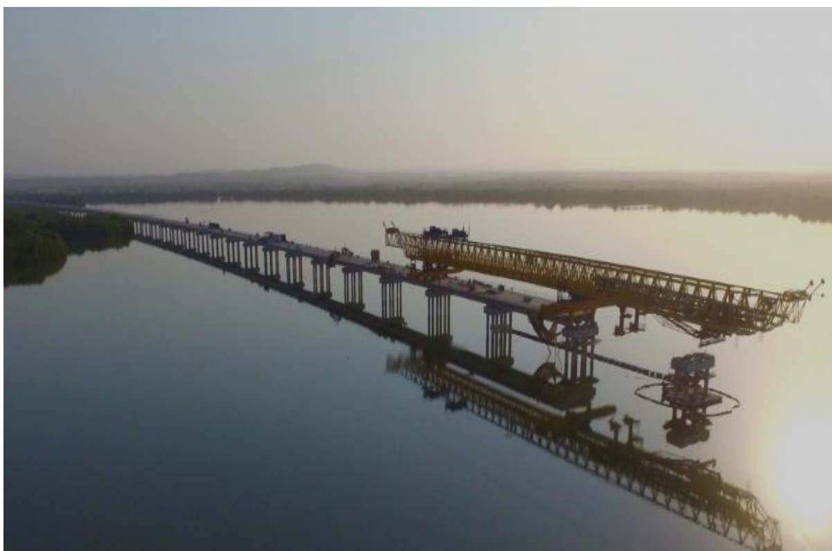
Figura 4: Viaducto el Gran Manglar. Fuente: PEDELTA.
