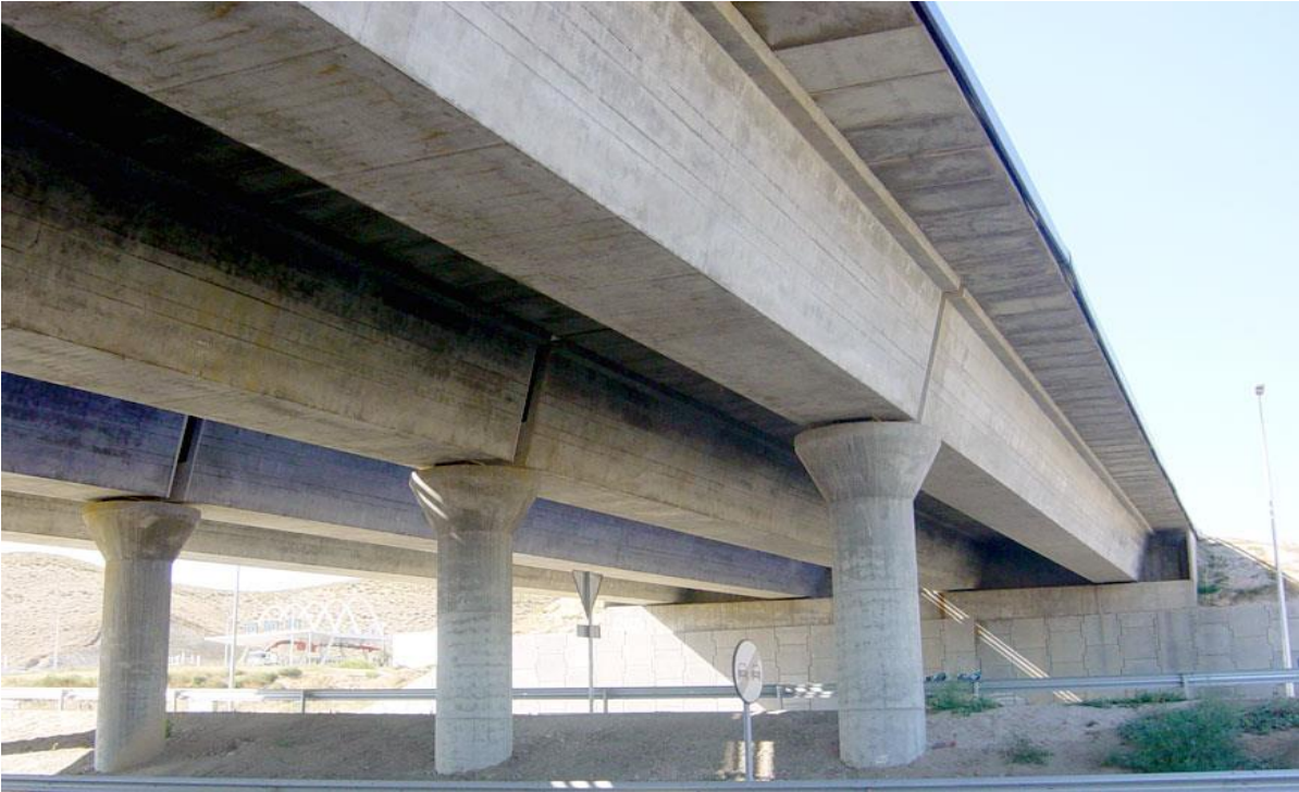
Figura 1: Puente Vigas Prefabricadas. Fuente: Propia.
