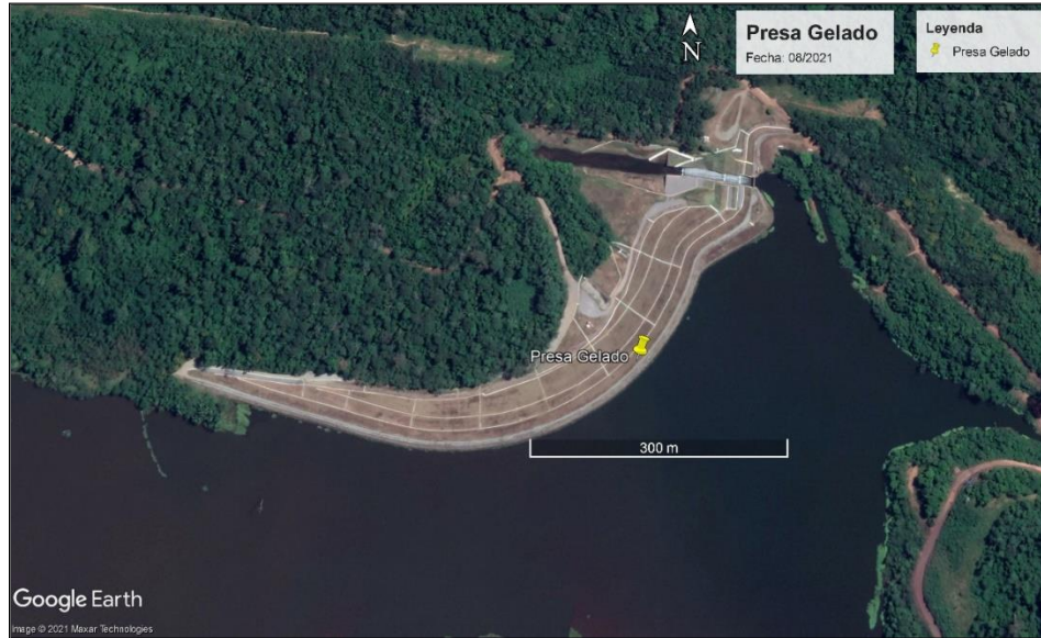
Figura 37: Presa Gelado. Coordenadas: -05^{\circ}58'45.400'' , -50^{\circ}08'29.100'' (Google earth, 2021)
