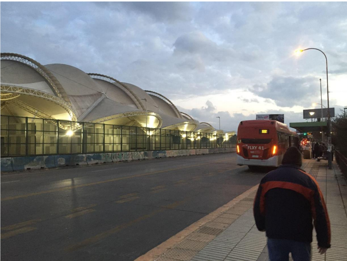
Figura 11. Estación del Sol, límite norte. Vista desde Avenida Los Pajaritos. Fuente: Archivo personal del autor.
