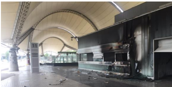
Figura 65: Fotografía de la estación Intermodal Del Sol un día de su incendio el 20 de octubre de 2019. Fuente: Hernández, 2019
