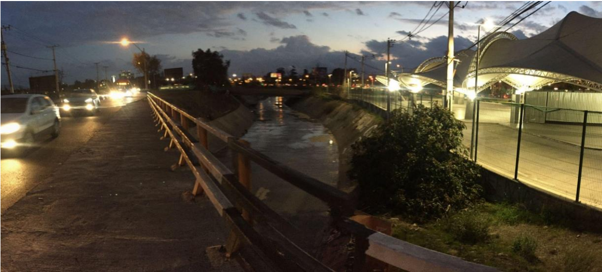
Figura 10. Intersección de Av. Los Pajaritos (sur) con Zanjón de la Aguada. Fuente: Elaboración propia, a partir de base aerofogoramétrica de Google Earth
