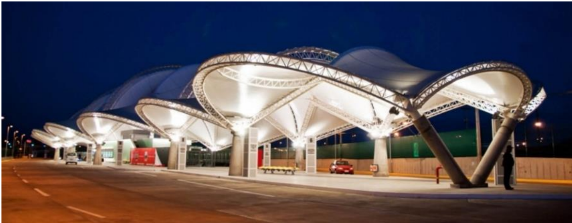
Figura 14. Fotografía del interior de la intermodal de la Estación del Sol. Fuente: BAC consultores.
