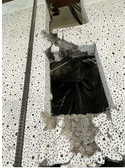
Figura 6.55: Estado Final de las Vigas de Acople al finalizar el ensayo
