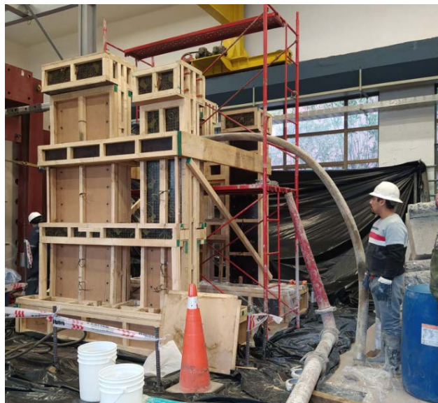
Figura 4.9: Hormigonado de la Probeta
