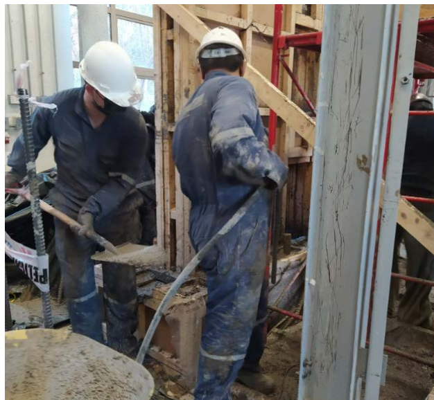
Figura 4.11: Hormigonado Manual y Vibrado de la Probeta
