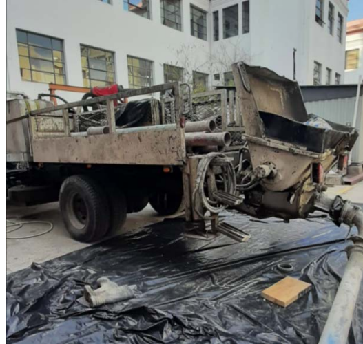
(b) Camión de Bombeo
