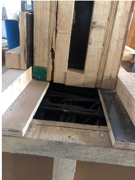
Figura 4.6: Escotilla en Moldaje de Pedestal
