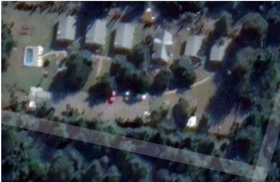
Ilustración 3: Imagen Satelital de Instalaciones de Maki Andino
