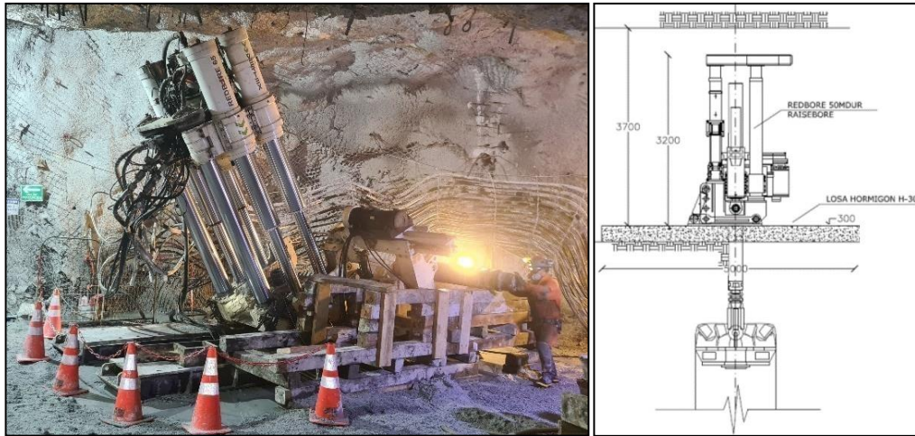
Figura 28: Excavación mecanizada de pique con metodología Raise Borer, equipo Redbore 65 de empresa Vertex en Nivel de Producción. Fuente: Gerencia Obras Mina, DET, Codelco.
