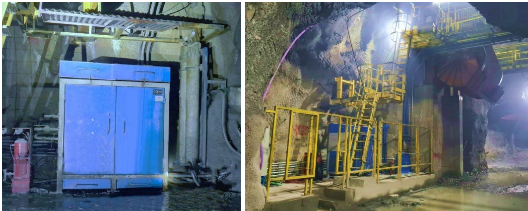
Figura 40: Habilitación hidráulica y eléctrica de buzón.
