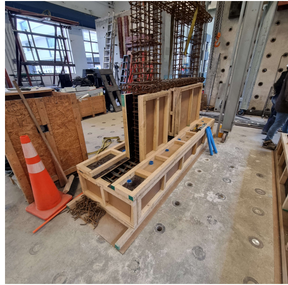
(b) Encofrado piso 1.
