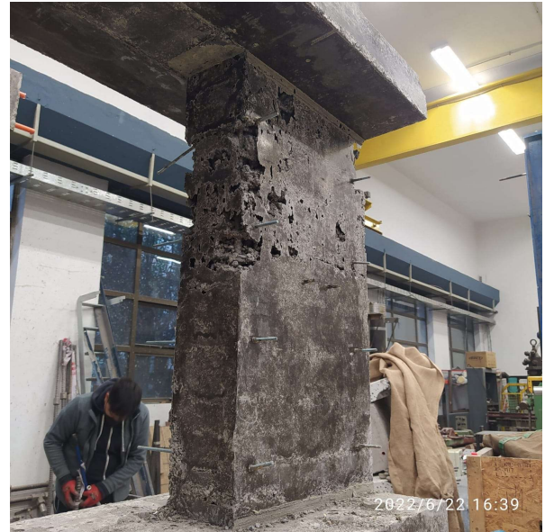
(b) Zona a reparar M2.
