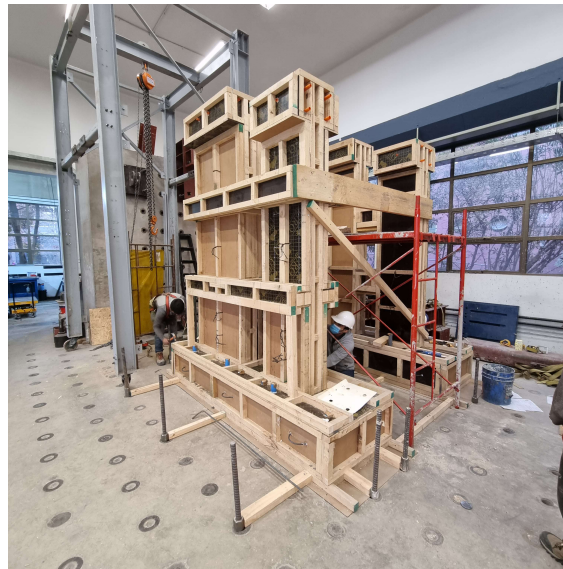
(c) Encofrado terminado.
