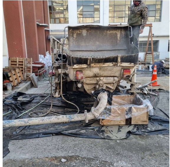
(b) Camión con bomba para hormigón.
