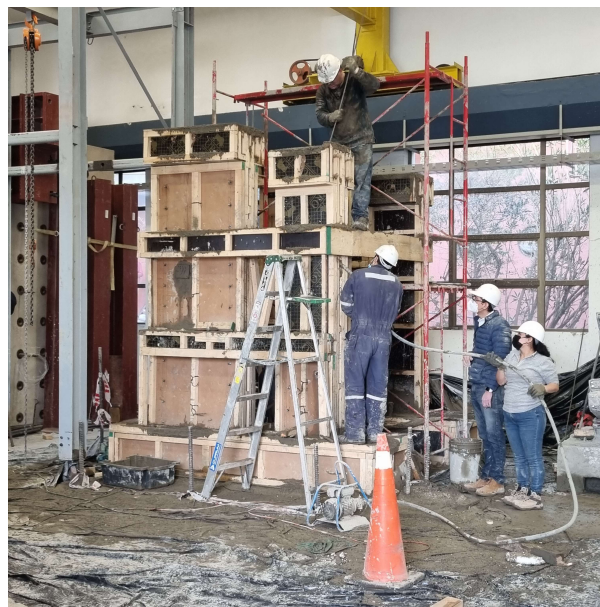
Figura 3.17: Enfierradura en terreno.
