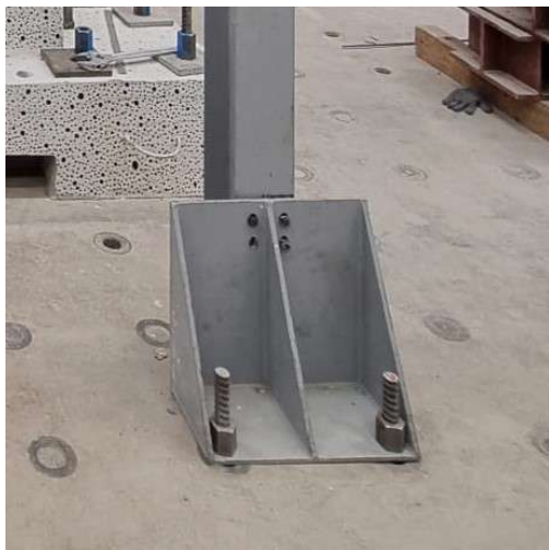
(a) Anclaje vista frontal.
