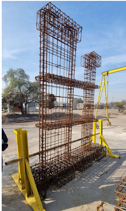
Figura 3.13: Enfierradura en terreno.
