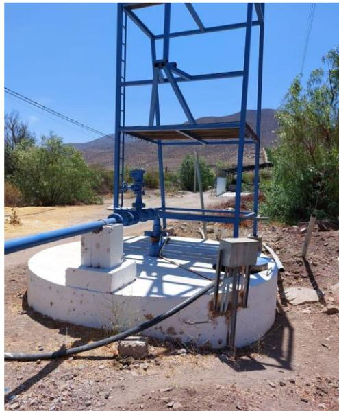
*Figura 37: Pozo tipo noria ubicado en la planta del APR.*
