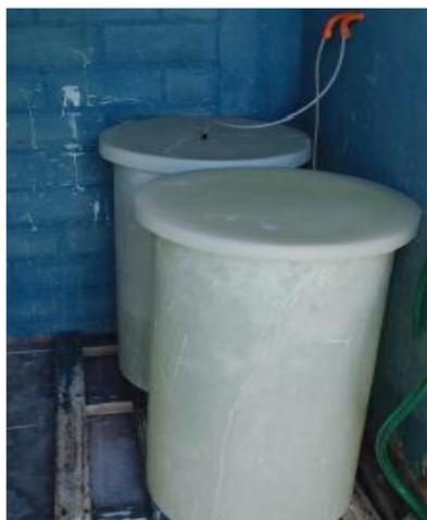
*Figura 29: Estanques para hacer solución de cloro.*
