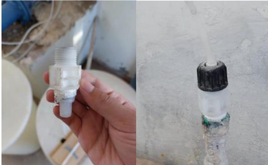
*Figura 47: Equipo dosificador e inyección de cloro.*
