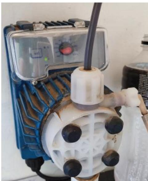
*Figura 15: Bomba dosificadora de permanganato de sodio.*
