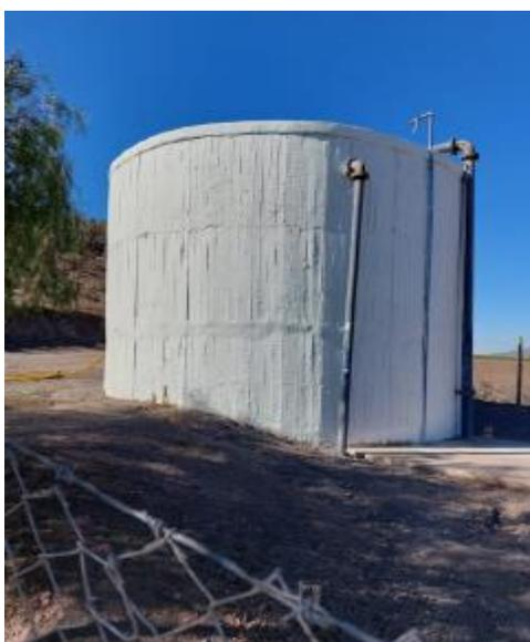
*Figura 44: Estanque semienterrado de 150 m<sup>3</sup> de almacenamiento.*
