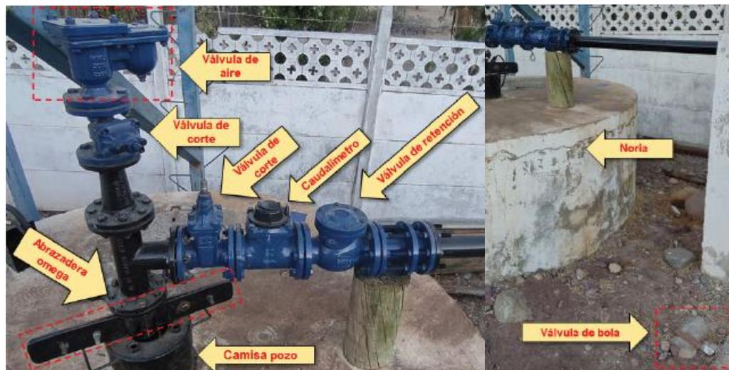
Figura 10: Elementos del pozo tipo noria.
