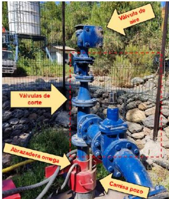
*Figura 11: Elementos del pozo profundo.*
