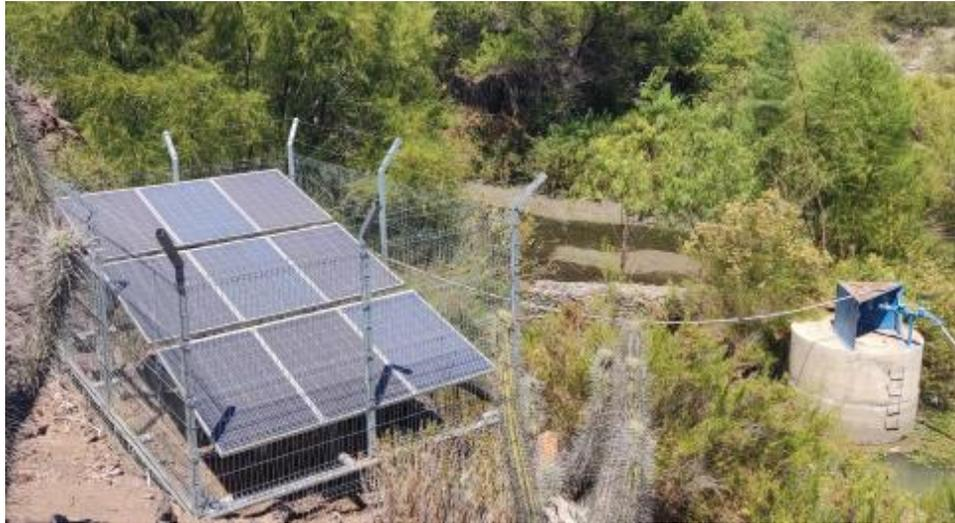
Figura 9: Paneles solares de vertiente La Ternera.
