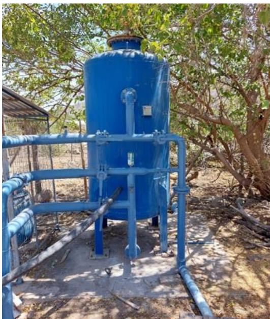
*Figura 40: Uno de dos sistemas de filtración del APR.*
