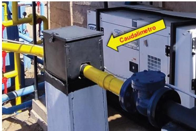
*Figura 27: Caja protectora de caudalímetro en caseta de operaciones.*
