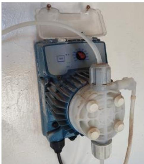
*Figura 16: Bomba dosificadora de cloro.*
