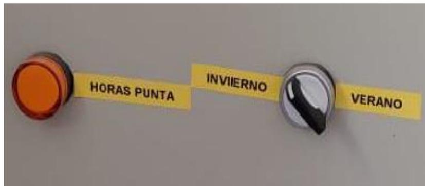
*Figura 46: Perillas e indicadores de horas punta de las bombas.*
