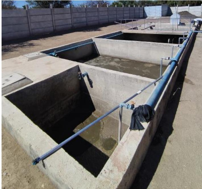
*Figura 25: Estanques de aireación, sedimentación y desinfección de la PTAS.*
