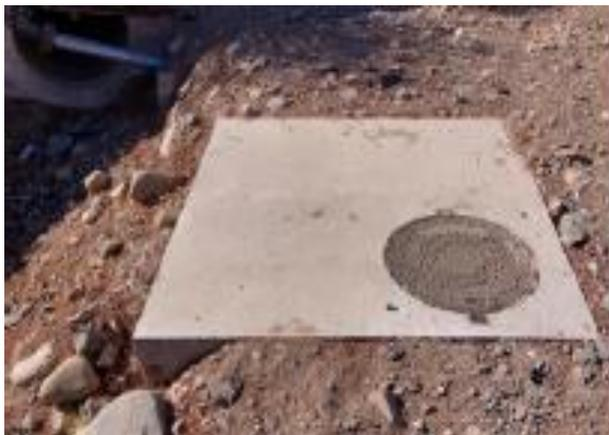
*Figura 43: Cámara de válvula de corte en el sistema de impulsión.*
