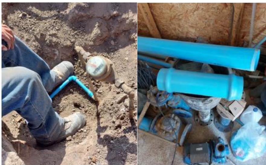
*Figura 52: Repuestos de cañerías para reemplazar en medidores y en matriz.*
