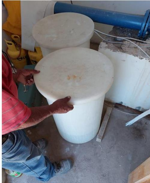
*Figura 41: Tanque para hacer y almacenar solución de cloro.*
