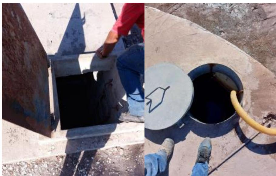
*Figura 45: Entradas a cámaras bajo y sobre el estanque respectivamente.*
