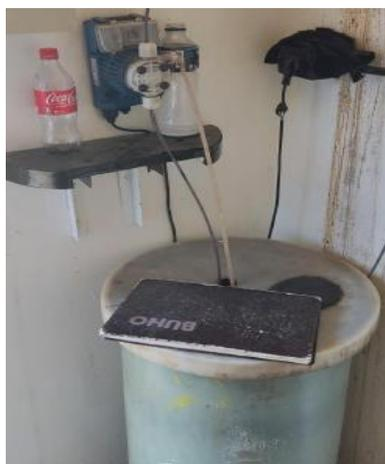
*Figura 30: Estanques para hacer solución de cloro.*
