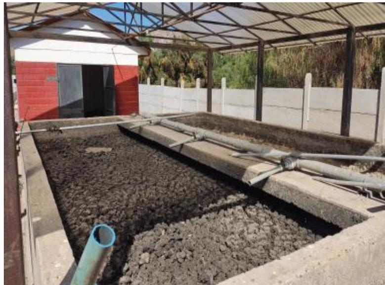
*Figura 26: Cancha de secado de lodos de la PTAS.*
