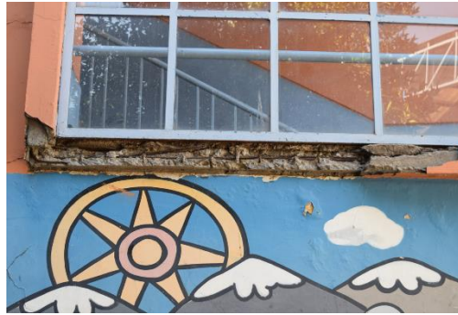
Figura 4-34: Armadura expuesta.
