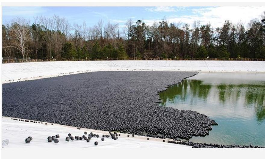
Figura 25. Bolas flotantes para disminuir evaporación
