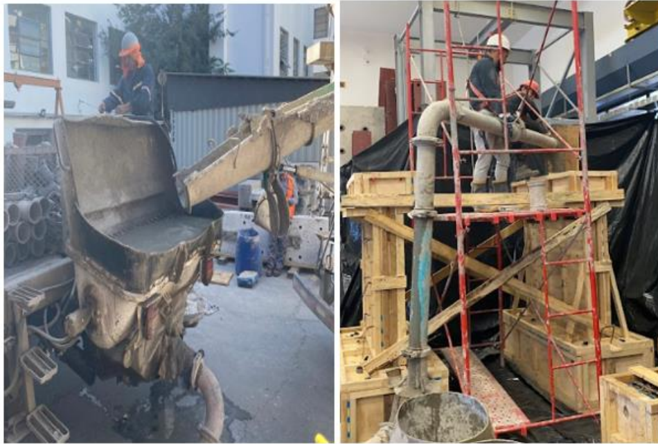
Figura 2.21: Vaciado de Hormigón en probetas
