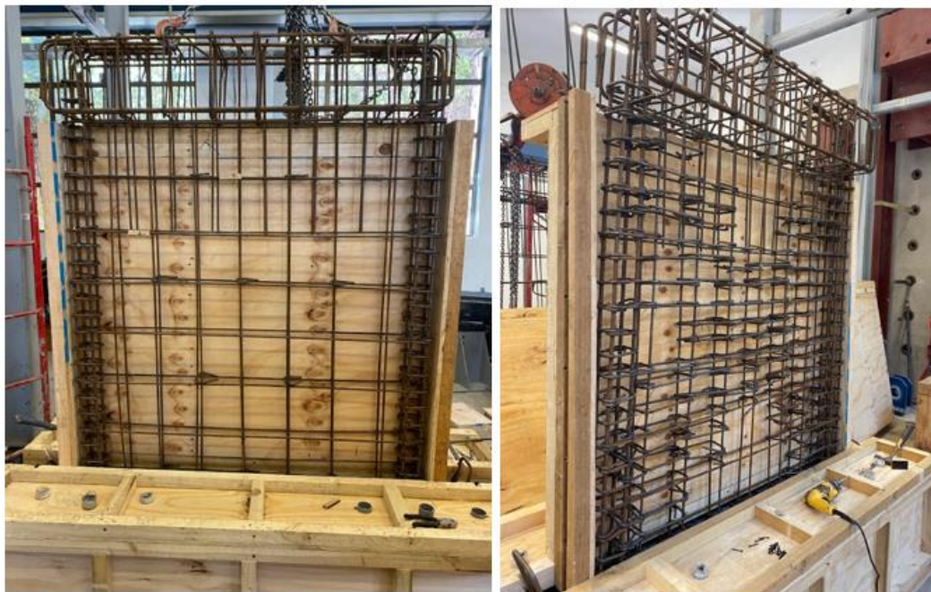
Figura 2.14: Moldaje Muros
