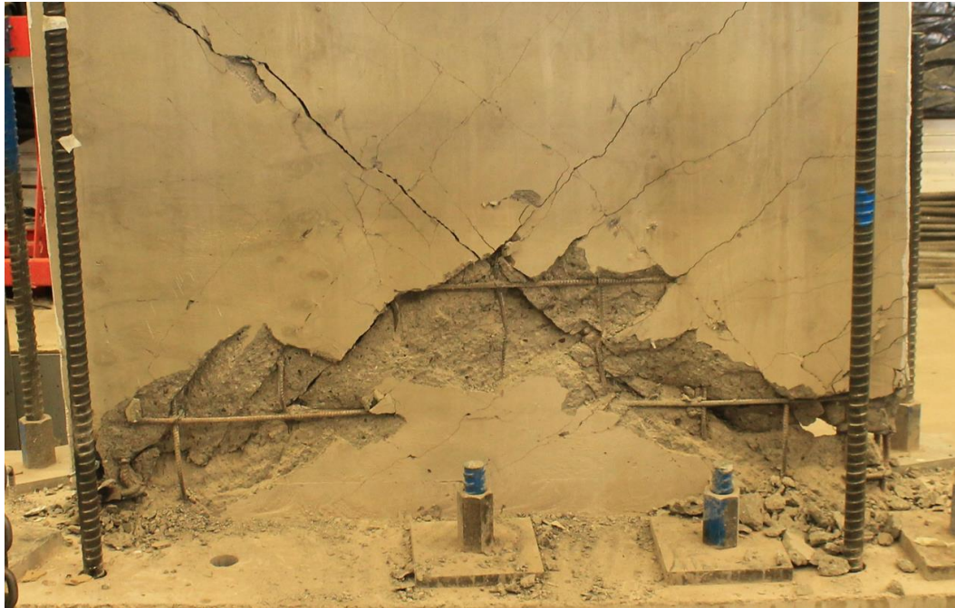
Figura 4.11: Estado Final Muro Convencional, Vista Lado Sur
