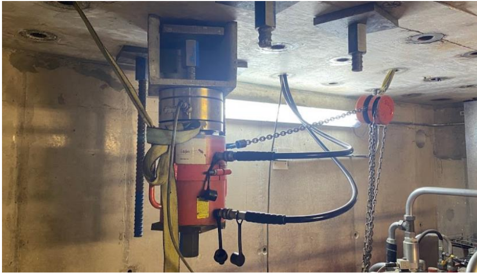
Figura 3.10: Maniobra de Postensado Inferior
