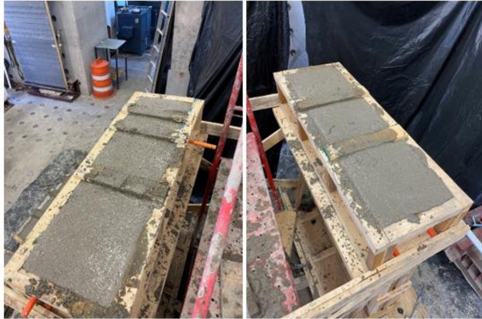
Figura 2.25: Enrasado final de superficie
