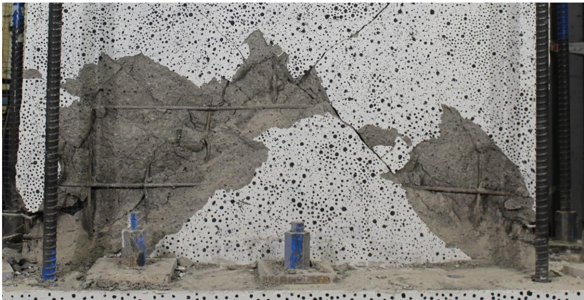
Figura 4.12: Estado Final Muro Convencional, Vista Lado Norte
