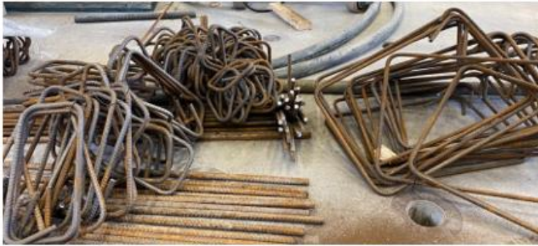
Figura 2.10: Doblado de Enfierradura
