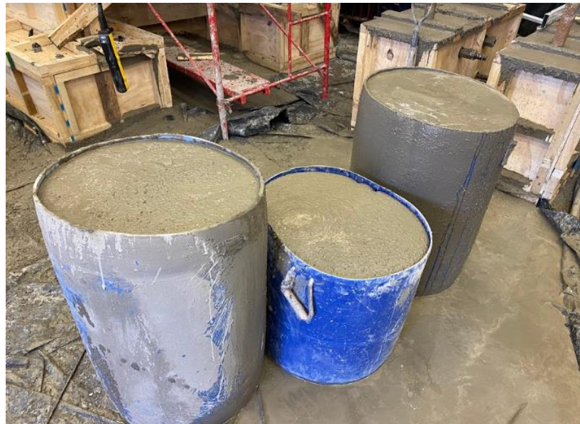
Figura 2.23: Llenado de Hormigón en tambores
