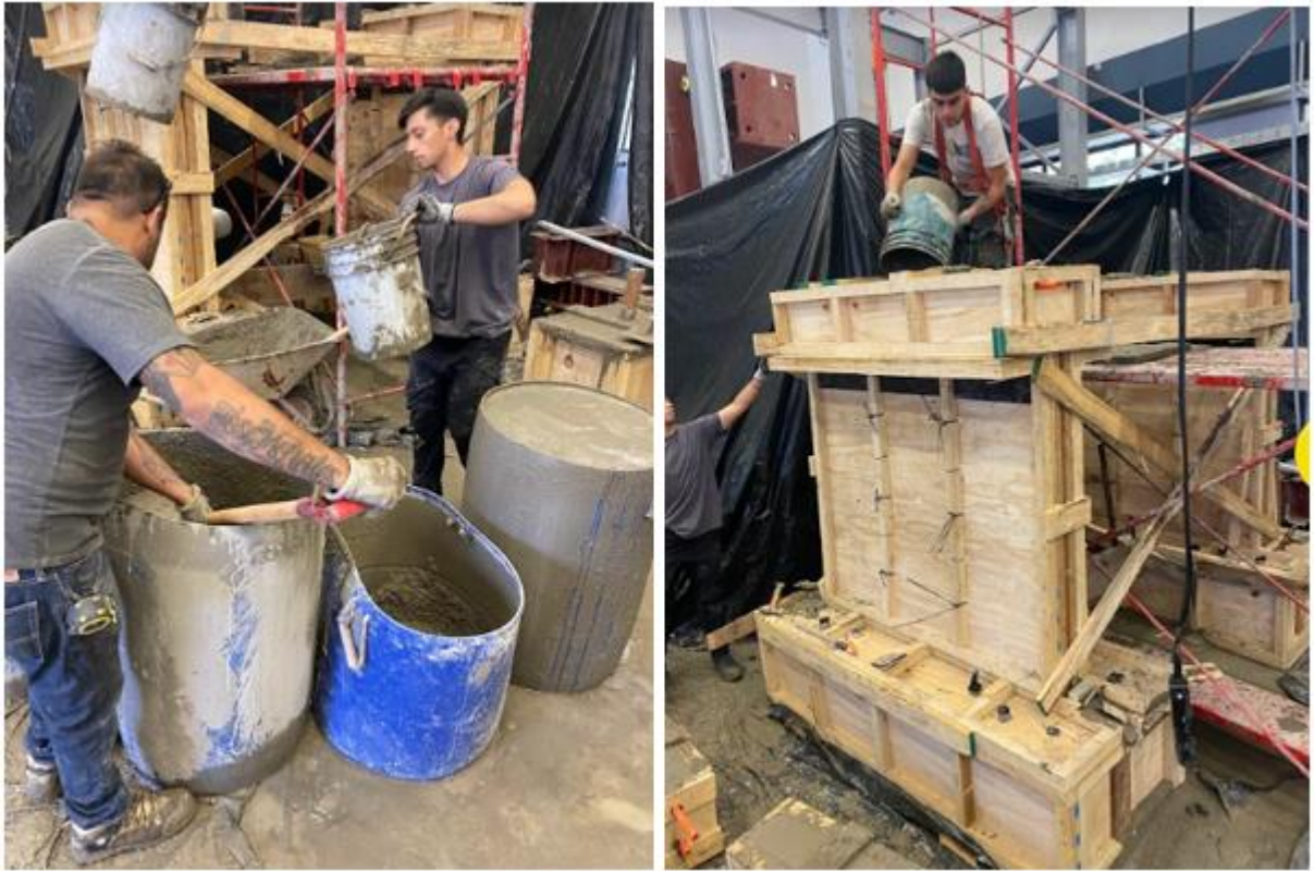
Figura 2.24: Maniobra de Hormigonado Manual
