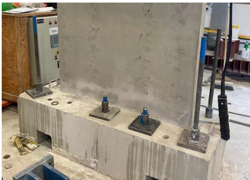
Figura 3.12: Vista General de Postensado de Anclaje
