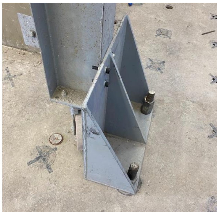
Figura 3.18: Topes Anclados Marco de Acero
