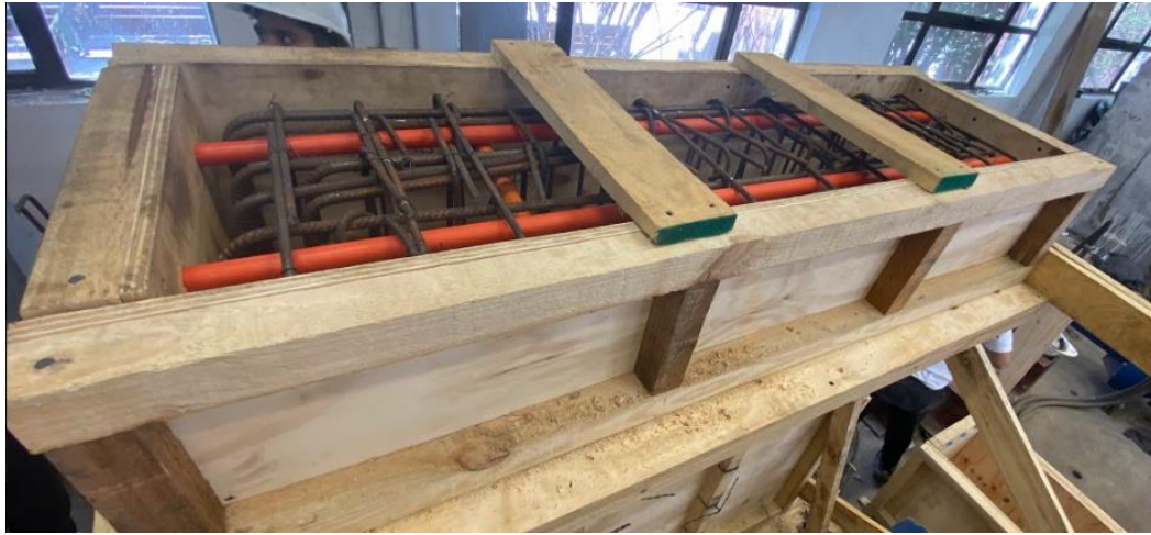
Figura 2.15: Moldaje Vigas
