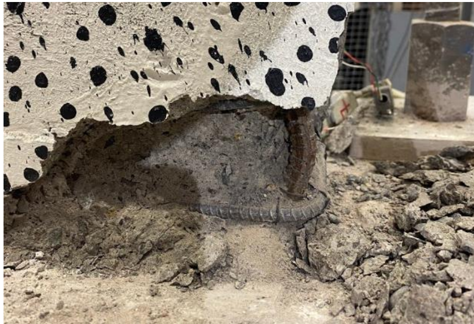
Figura 4.27: Pandeo de barras longitudinales lado oeste
