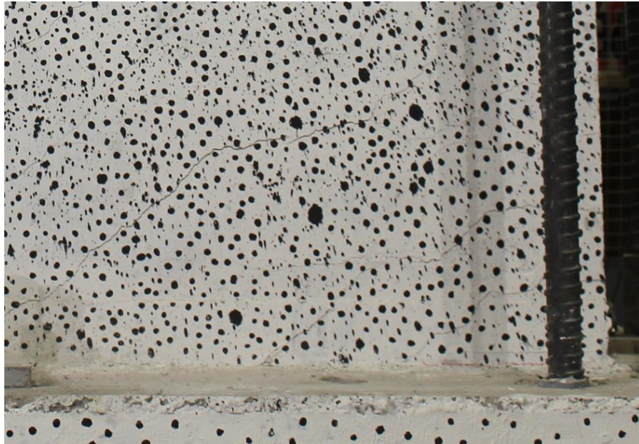
Figura 4.24: Grietas primer ciclo deriva 0,75%
