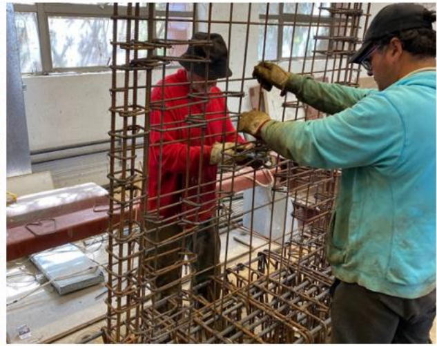
Figura 2.11: Ensamblado del esqueleto estructural
