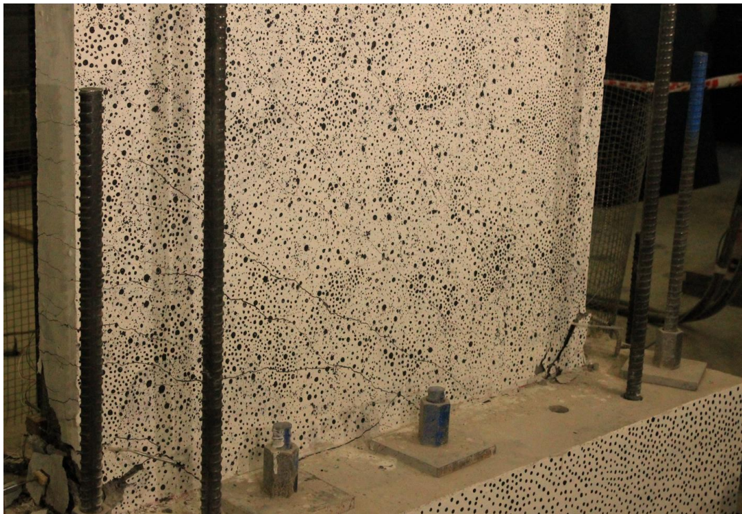
Figura 4.6: Grietas primer ciclo deriva 2,0% (Oeste)
