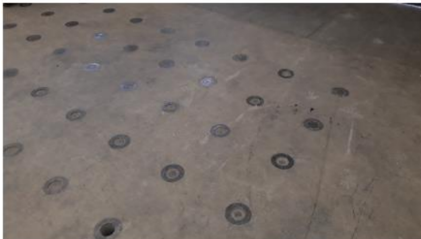
Figura 3.3: Losa de Reacción
