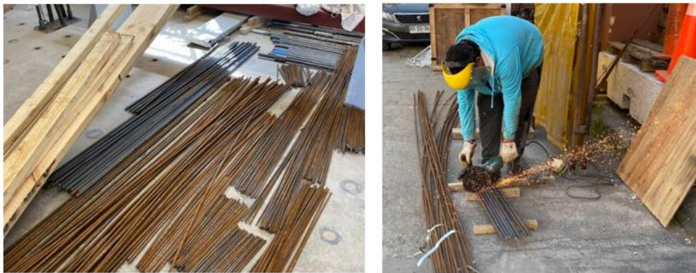
Figura 2.9: Corte de Enfierradura
