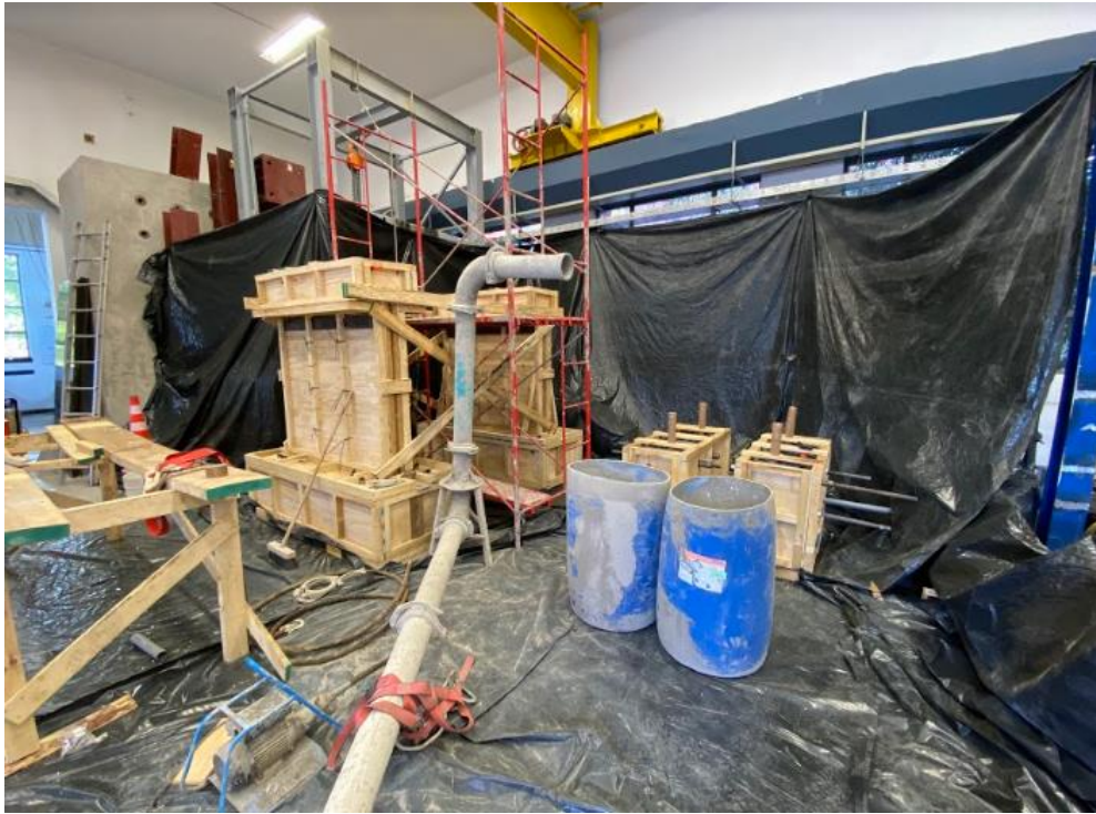
Figura 2.17: Preparación previa a Hormigonado
