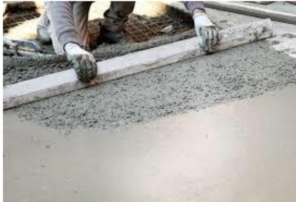
Figura 25: Terminación manual de superficie de hormigón.
