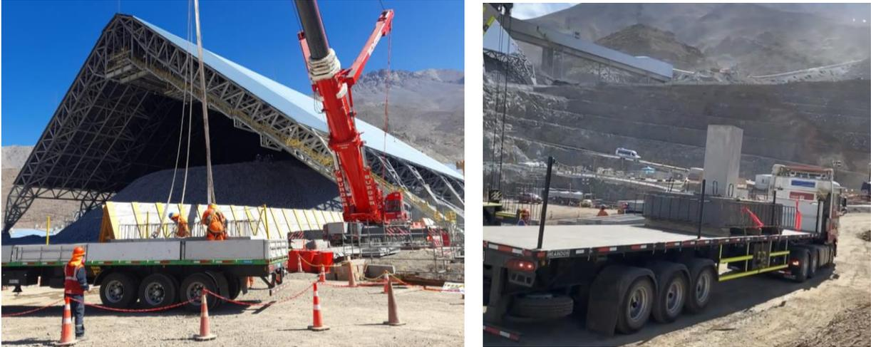
Figura 29: Camiones rampla plana cargados con elemento prefabricado (tomadas por alumno).
