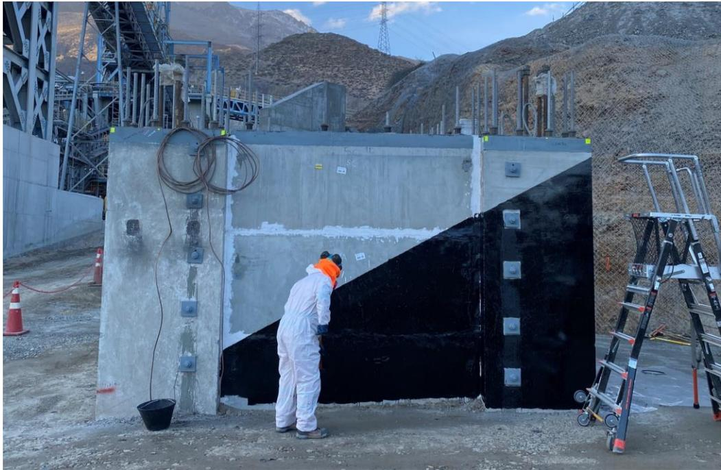
Figura 20: Fundación prefabricada con sistema de insertos con pernos (tomada por alumno).
