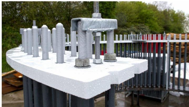
Figura 13: Elementos guía para insertos.
