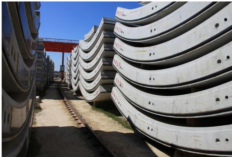
Figura 26: Acopio de dovelas prefabricadas.
