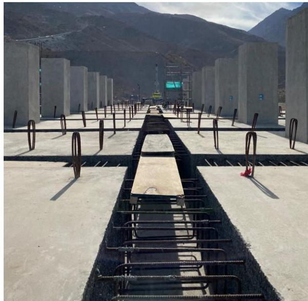
Figura 21: Sistema de izaje temporal con torones en prefabricados pesados de hormigón (tomada por alumno)
