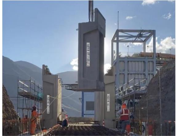
Figura 37: Montaje de muro prefabricado de 35 toneladas (tomadas por alumno).
