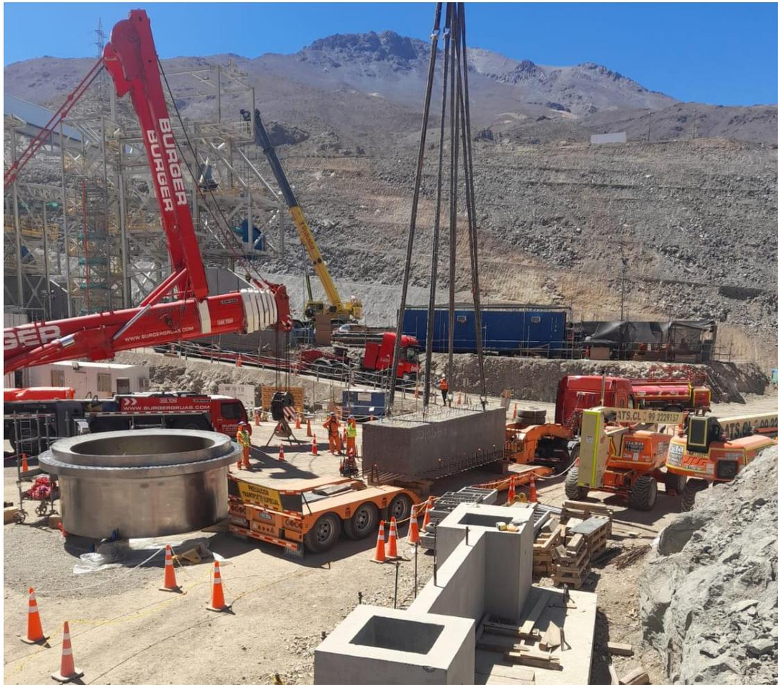
Figura 28: Descarga de elemento prefabricado pesado de hormigón en faena minera con espacio reducido (tomada por alumno).
