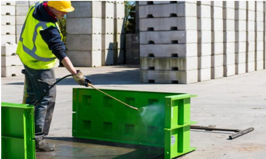
Figura 16: Aplicación de desmoldante en superficie interior de moldajes.
