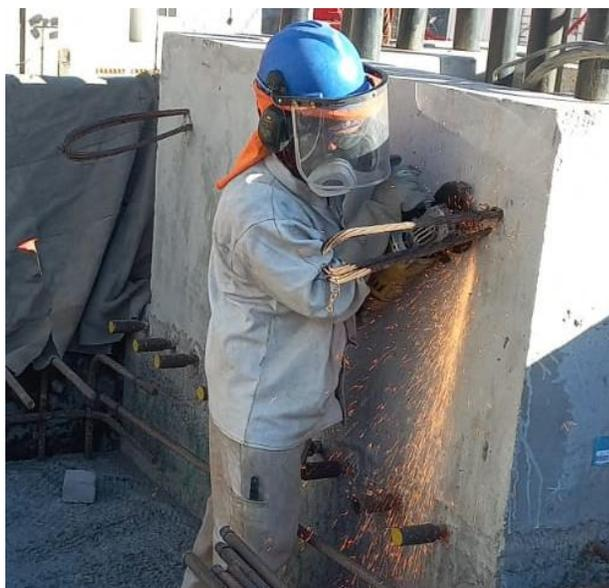
Figura 39: Corte de punto de izaje luego de montaje (tomada por alumno).
