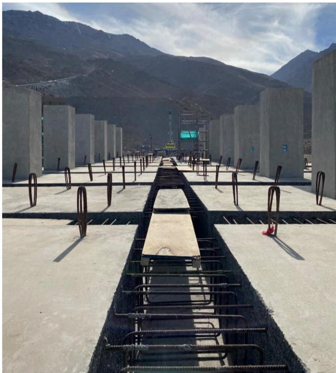
Figura 6: Losa de fundación con prefabricados tipo 3 para sala eléctrica (tomada por alumno).
