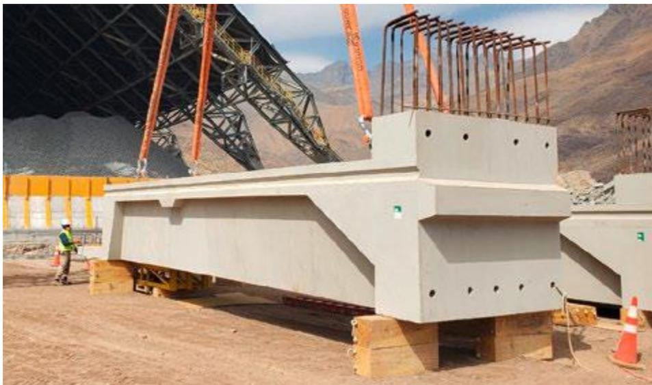
Figura 1: Izaje de prefabricado pesado de hormigón en minería.
