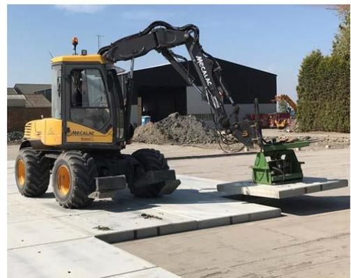
Figura 4: Acopio y montaje de elementos prefabricados tipo 2.
