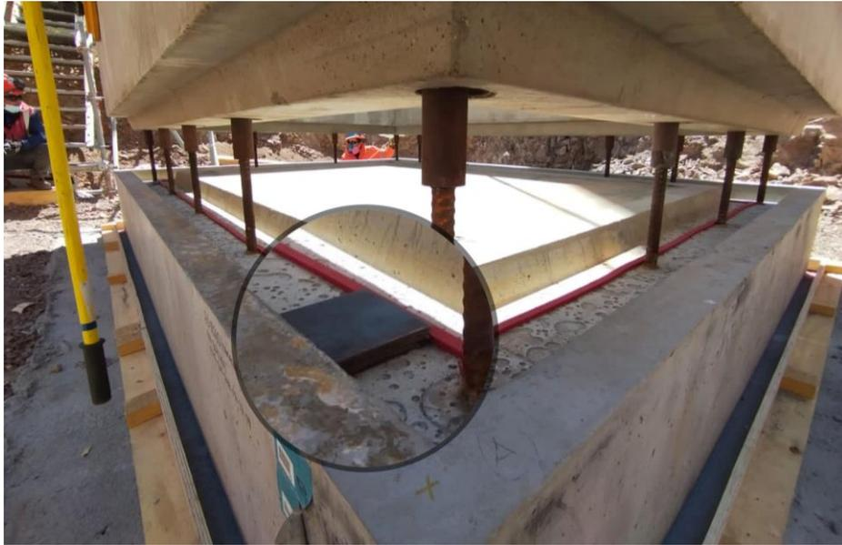
Figura 43: Instalación de placa de nivelación para cajón prefabricado. (tomada por alumno)
