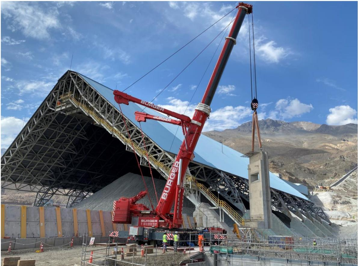
Figura 36: Montaje de muro prefabricado de 75 toneladas (tomada por alumno).
