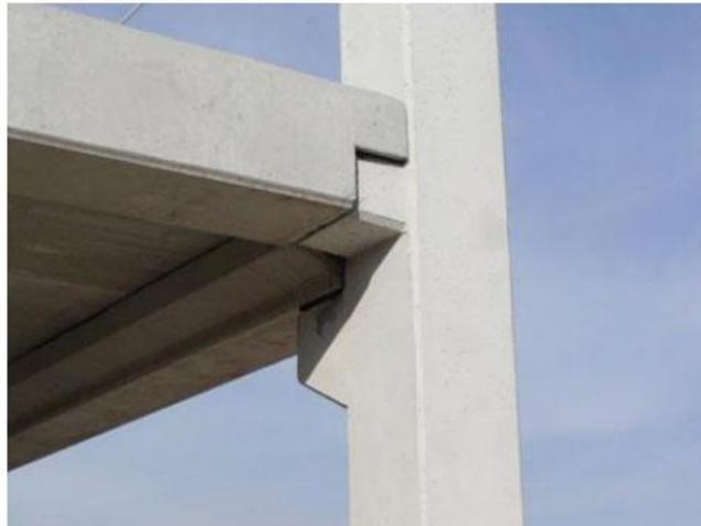
Figura 7: Conexión viga-columna, mediante ménsula, de elementos con unión tipo 4.
