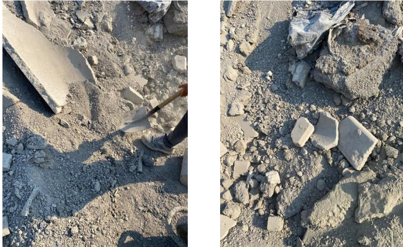
Ilustración 11: Estado de los residuos (c)
