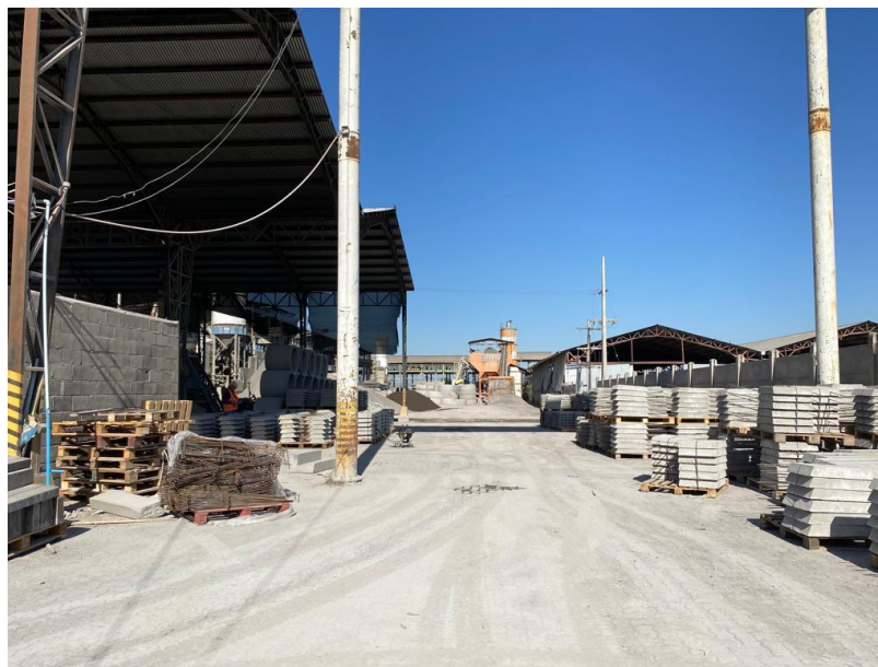
Ilustración 8: Planta de prefabricados Bottai
