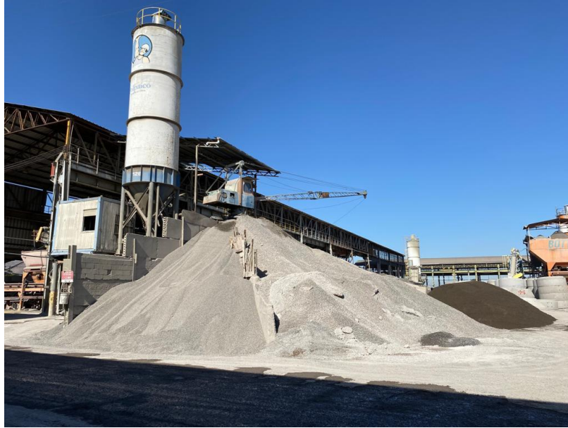
Ilustración 20: Betonera de la planta Bottai
