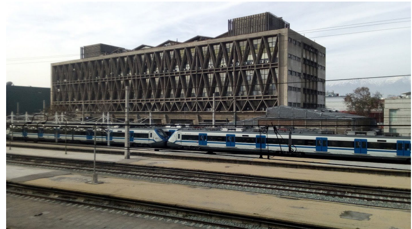
Fig n°25 Fotografía desde terminal san Borja, límites duros con respecto a la línea férrea y deterioro fachada sur Fuente: Elaboración propia
