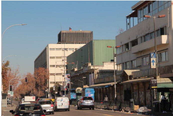
Fig n°24 sup: Acercamiento al proyecto desde alameda, se aprecia el deterioro urbano del espacio público Fuente: Elaboración propia
