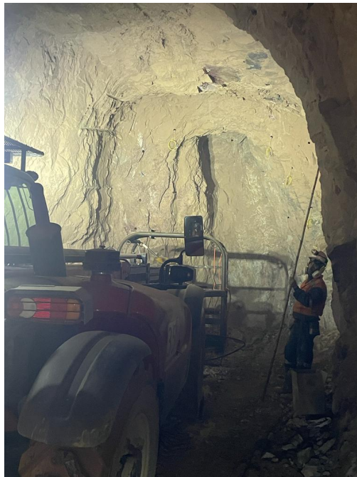
Figura 4.21: Resultado de tronadura split blasting .
