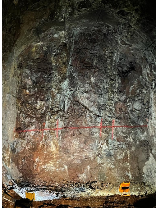
Figura 4.20: Frente marcada con split blasting .
