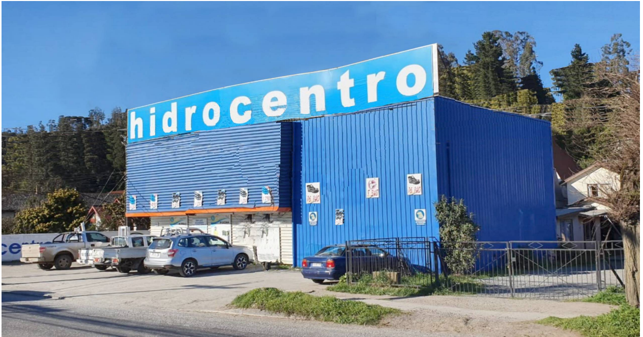
Figura A.3: Imagen frontal de la sucursal San Pedro en Concepción. Fuente: Hidrocentro (2020). Frontis San Pedro . Publicado en https://www.hidrocentro.cl
