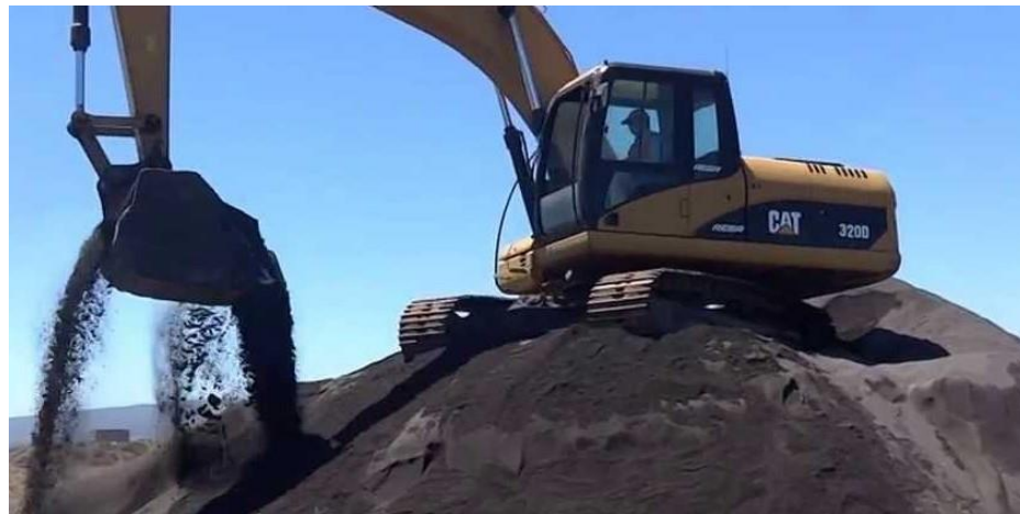
Figura 8: Extracción de relaves y preparación de cancha (elaboración propia)
